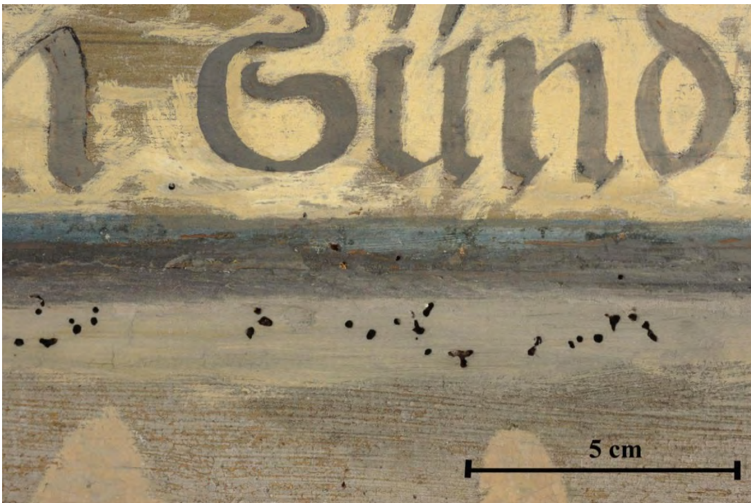
Abb. 35: Vorzustand, Ausflugslöcher eines inaktiven Anobienbefalls, Übergang obere Schrifttafel und Mitteltafel.
