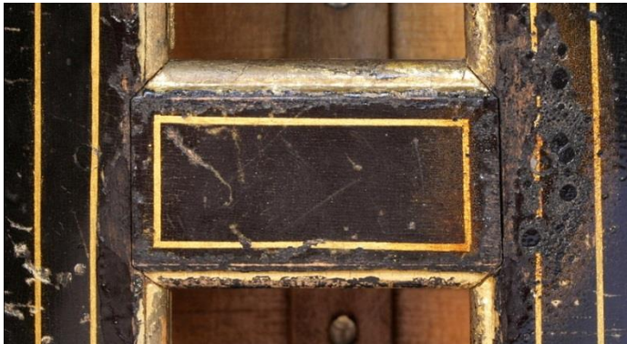
Abb. 23: Steg zur Unterteilung der Schallöffnungen Auf die Rippen wurden profilierte Stege geleimt, die den Spalt zwischen den Schalenhälften in fünf einzelne Öffnungen unterteilt. Die Rippen sind neben den Stegen an die Korpuschale geschraubt.
