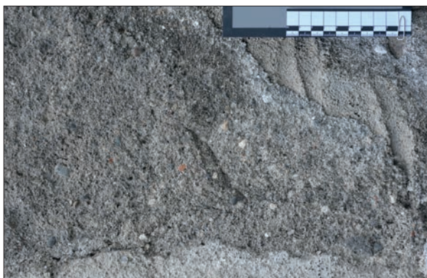
Abb. 11: Grabbau EN 4: Zweite Unterputzschicht mit Kalkgallen und auffälligem Anteil an Grobkorn.
