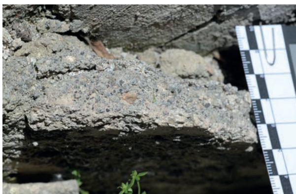
Abb. 9: Dreischichtiger Putzaufbau der Ostseite von Grab EN 4 mit auffällig hohem Großkornanteil in der zweiten Unterputzschicht.
