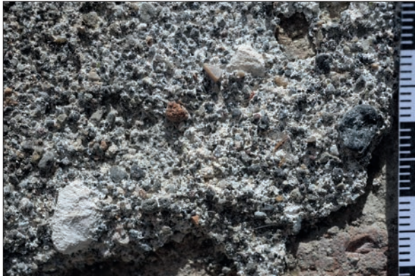
Abb. 13: Grabbau EN 4: Erste Unterputzschicht mit Kalkgalle und einem auffälligem Anteil an Kornklassen zwischen 0,5 und 1 mm, bei vereinzelt Größtkorn bis etwa 7 mm. Die Farbigkeit der Matrix ist heller als bei Schicht 2 (Abb. 15).
