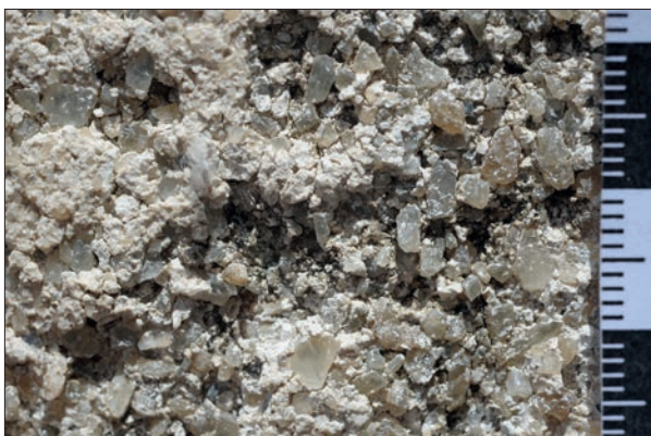
Abb. 16: Grabbau EN 4: Oberputz mit sparitischem Calcit im Kornklassenbereich von überwiegend 1 bis 2 mm, vereinzelt bis 3 mm. Die Oberfläche zeigt ein auffälliges Schadensbild mit Bindemittelfehlstellen und Abschalungen.
