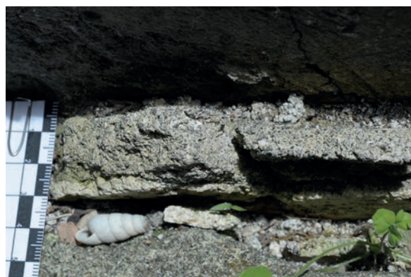
Abb. 10: Vierschichtiger Putzaufbau der Westseite von Grab EN 6.
