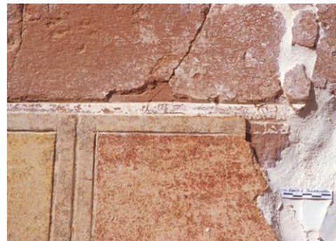
Abb. 58. Dunkler, sandiger Unterputz mit
