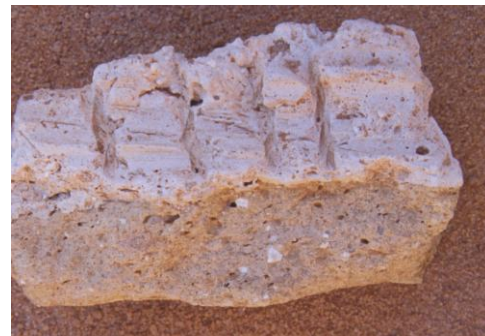
Abb. 10. Putzschichten auf Schilfrohr
