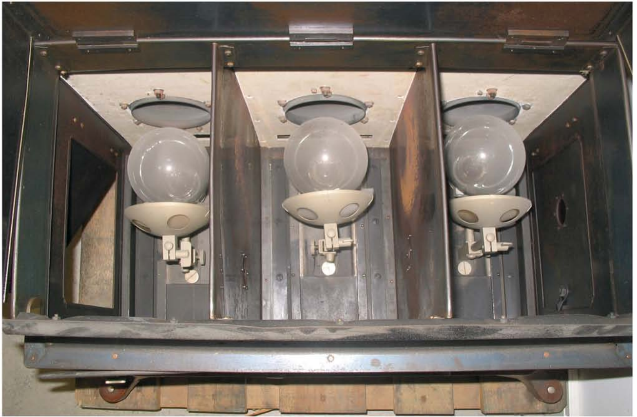
Lampenhaus innen, Glühlampen
