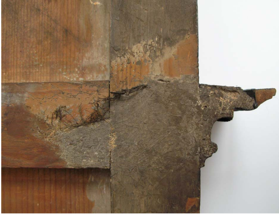
Abb. 30 Rückseite; Wergüberklebung über der Schlitz- und Zapfenverbindung und dem aufgesetzten Gesimsprofil
