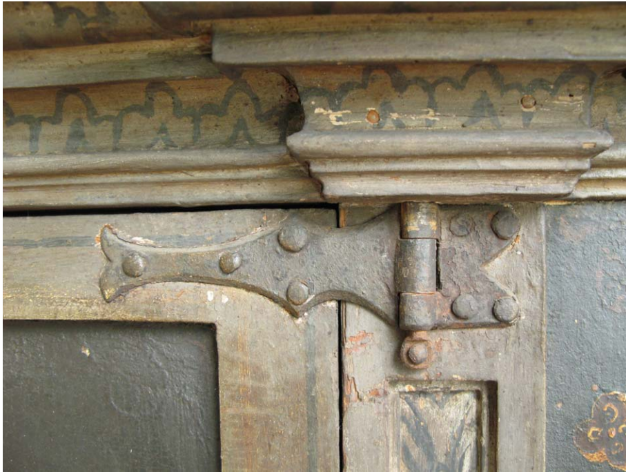
Abb. 22 rechtes oberes Band mit ursprünglicher Verbindung der Bandlappen; darüber mit Nägeln nachträglich befestigtes Profilstück
