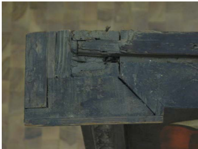
Abb. 28 Aufsicht linke äußere Verkröpfung; Profilergänzungen, abgesägter Fries/Pilaster, Schlitz- und Zapfenverbindung, Nut einer entfernten Tafel
