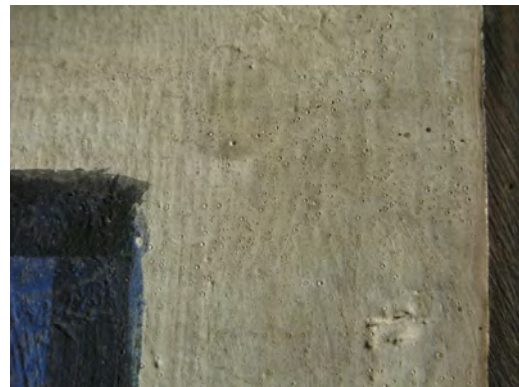
Abb. 113: Schrein, Ausmalung, Decke, Blasenbildung
