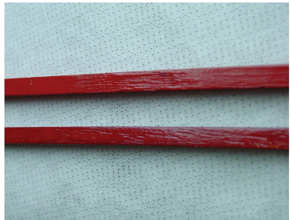
Abb. 63 Sichtbare Seiten der Abdeckleisten Oben original; unten Ergänzung
