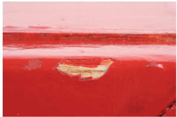
Abb. 12 PONG, Ecke oben rechts Fehlstelle mit ablesbarem Schichtenaufbau
