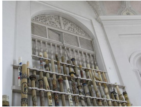
Abb. 12: Öffnung zum Kirchenraum, Blick von der Kirche.
