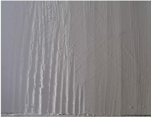
Abb. 77: Spuren eines Schropphobels.
