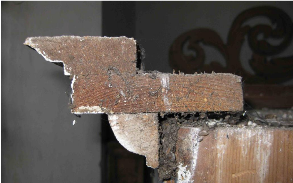
Abb. 131: Schrank, dreiteiliges Gesims, Ansicht von der Rückseite.
