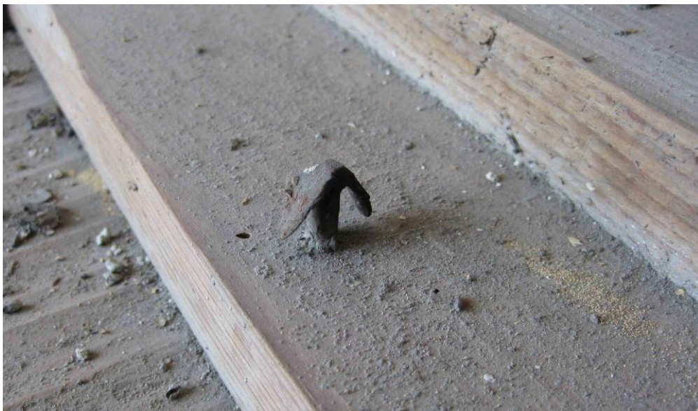
Abb. 132: Schrank, Befestigung Gesims an der Deckplatte.
