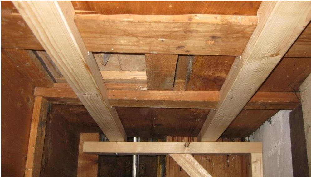
Abb. 89: Altartisch, Blick auf stützende Unterkonstruktion.
