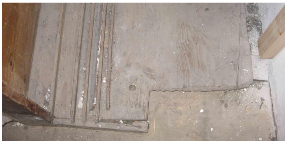
Abb. 87: Altartisch rechte Seite, Bodenplatte mit schmalen Leisten und Aussparung für Schrank.
