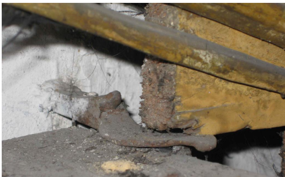
Abb. 100: Retabel, Befestigung des Gesimses mit einem geschmiedeten Vierkanteisen mit zungenförmig ausgeschmiedeter Spitze an der Wand.
