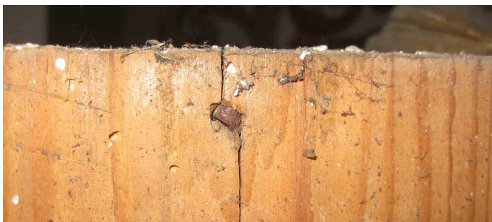
Abb. 130: Schrank, Befestigung Bretterrückwand an der Deckplatte.
