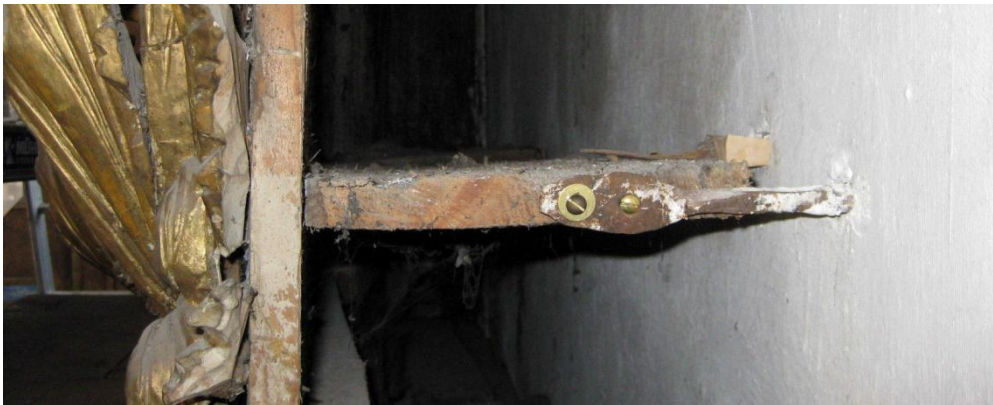
Abb. 28: Retabel, Befestigung an der Wand.
