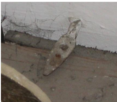
Abb. 54: Befestigung der Schränke an der Wand.
