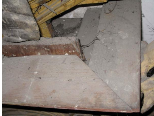
Abb. 22: Befestigung der Bretter im Gesims.
