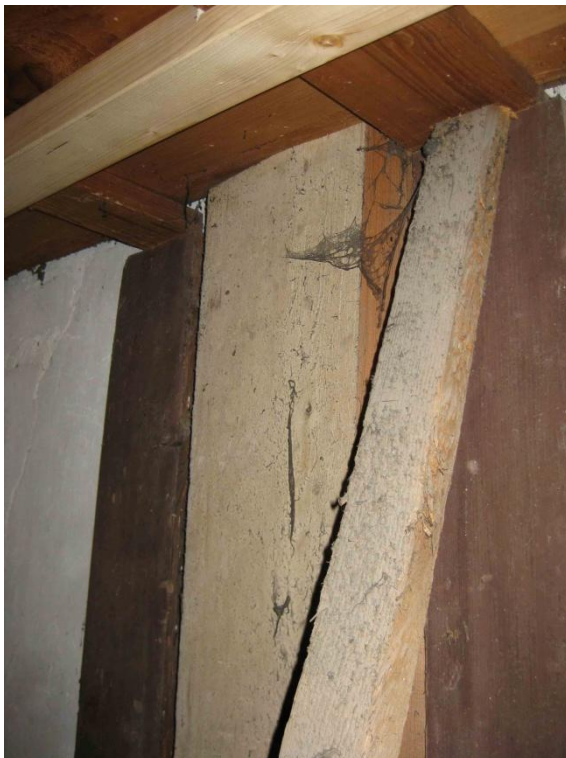
Abb. 90: Altartisch, Stützkonstruktion an der Wand.
