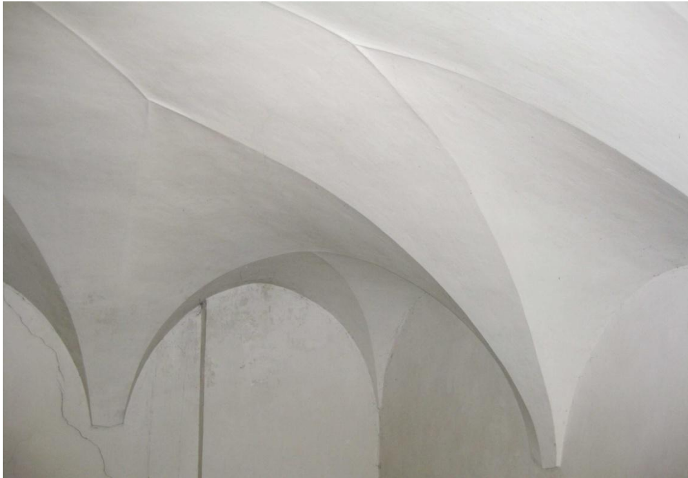
Abb. 10: Gewölbe der Kapelle.
