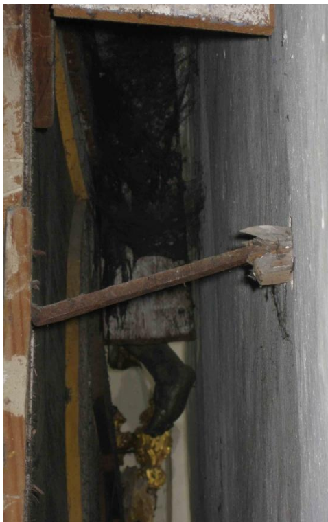
Abb. 102: Retabel, Befestigung der Unterkonstruktion an der Wand.
