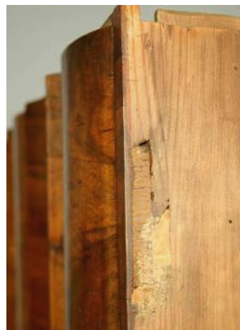
Abb. 84: Rückseite mit Seitenteil, Zapfenende mit Kittung
