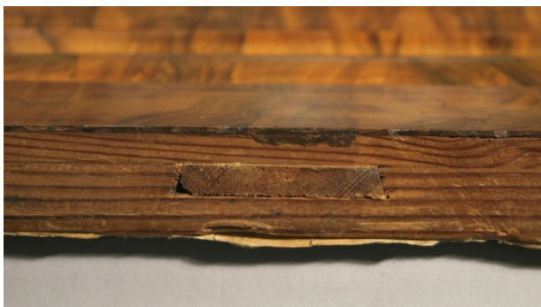
Abb. 83: Innere Türkante, Zapfenende
