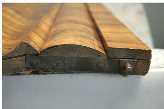
Abb. 77: Rechte Tür mit Zapfenbandunterteil
