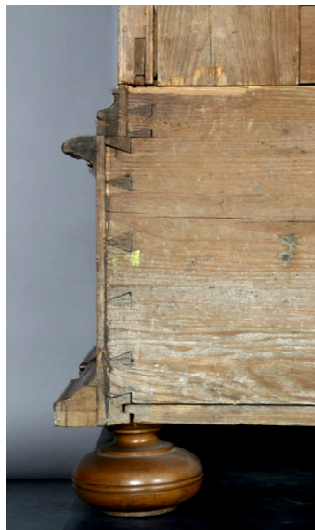
Abb. 56: Konstruktion der Sockelrückseite
