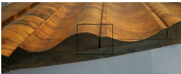
Abb. 89: furnierte Profile auf Trägerholz (Tür)
