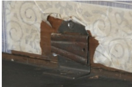
Abb. 10: Keilverschluss aus Stahlblech
