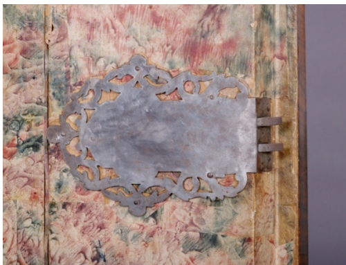
Abb. 45: Einlassschloss mit polierter Schlossdecke (Foto: MONIKA RUNGE, GNM)
