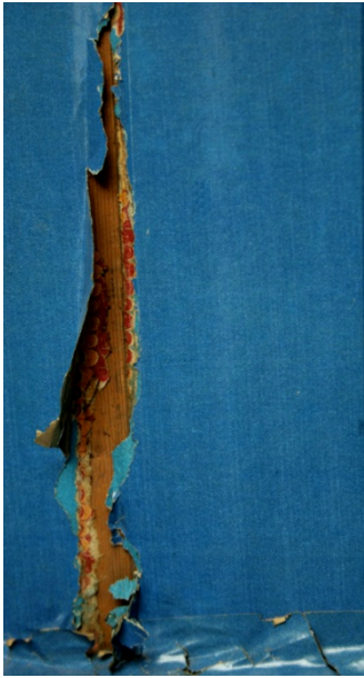
Abb. 78: Riss in Papierauskleidungen
