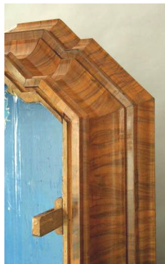
Abb. 86: Giebelunterseite mit Zapfen für Keilschließe
