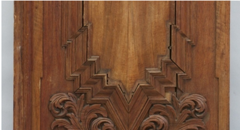
Abb. 123: Rechte Tür, Füllung mit Holznägeln fixiert
