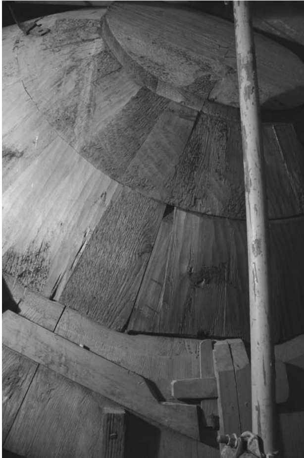
Abbildung 30: Konstruktion der Gloriole
