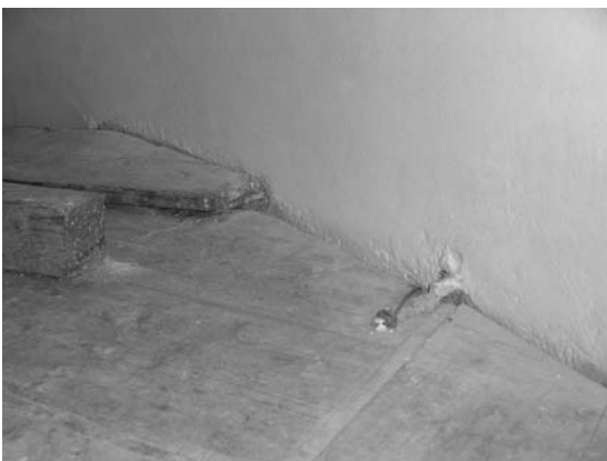
Abbildung 24: Stabilisierende Eisen am Gebälk
