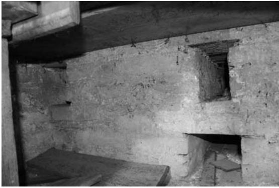
Abbildung 14: Belüftungsöffnungen am Stipes
