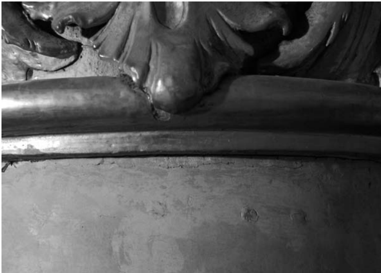
Abbildung 22: Kreisrund verlaufende Holznägel am Säulenschaft
