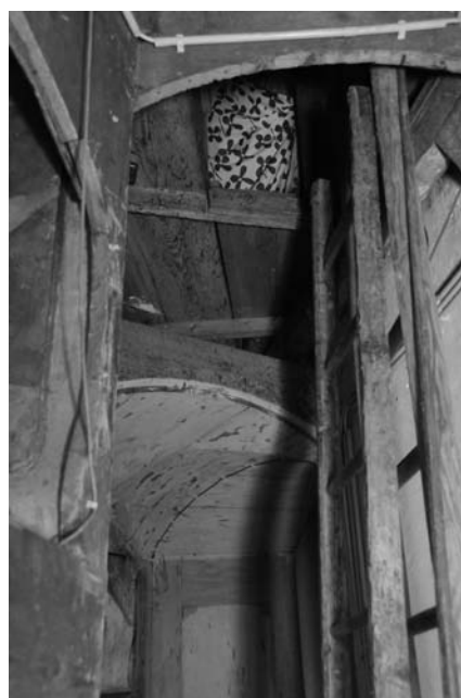
Abbildung 19: tragende Konstruktion des Bretterbodens
