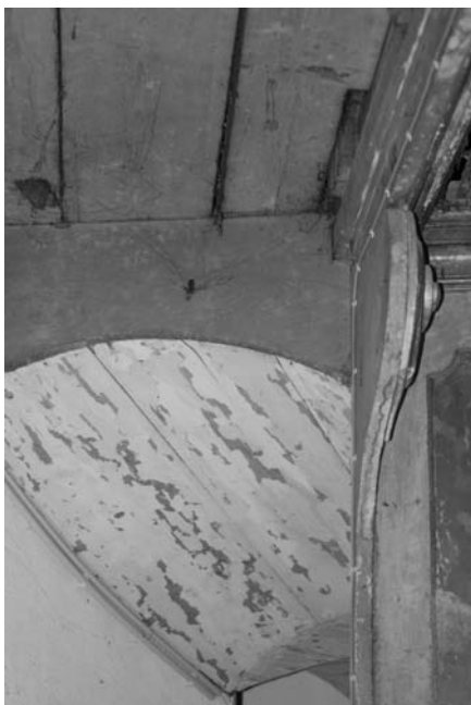
Abbildung 18: Durchgehende Profilleiste der Postamente
