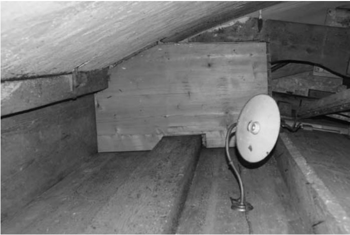
Abbildung 20: Retabelrückwand mit aufsitzendem Gebälkstück
