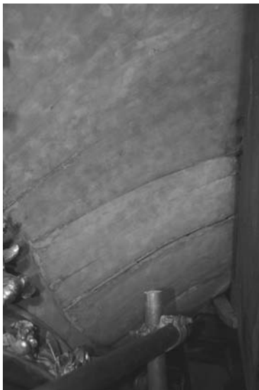
Abbildung 28: Schräg eingesetzte Bretter am Baldachin
