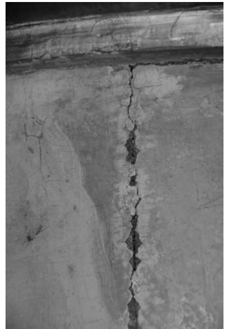
Abbildung 21: Kaschierte Brettfuge am Säulenschaft
