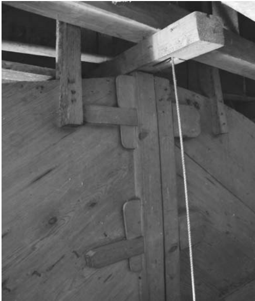
Abbildung 25: Diagonal verlaufende Bretter an der Rückwand des Baldachins
