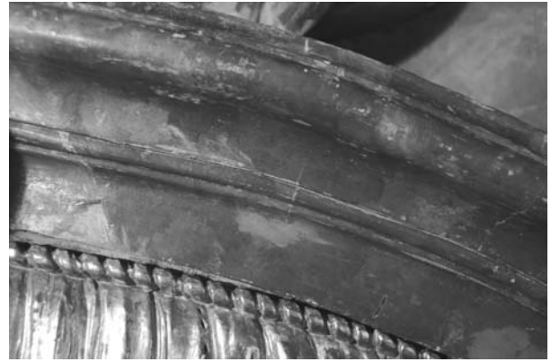
Abbildung 26: längs aneinander gestückte Bretter an den Profilen des Baldachins
