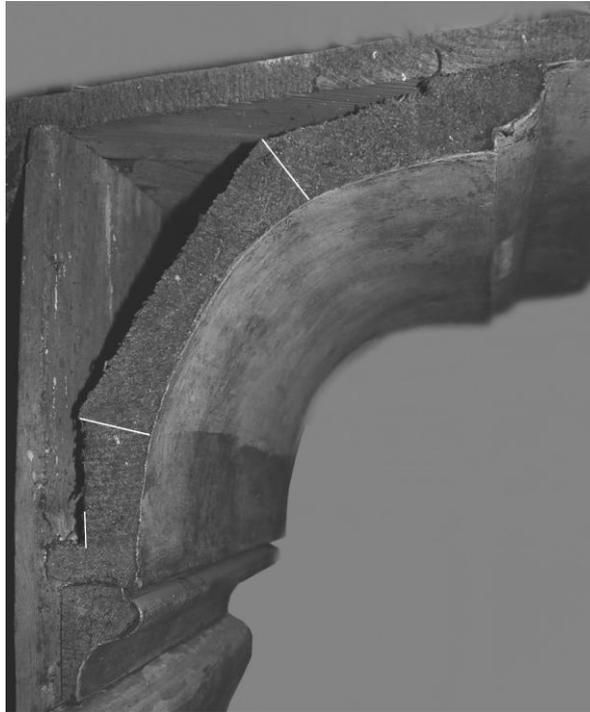
Abb. 37. Hochaltar, nördliches Gebälkstück, Ansicht von Osten: Hier zeigt sich exemplarisch die Konstruktion der Kehlen des Kranzgesimses. Die Holzstöße sind durch weiße Linien veranschaulicht. Die Profile des Hochaltars werden im Gegensatz zum nördlichen und südlichen Retabel nicht mit einem Halbrundstab beendet sondern mit einem Viertelstab.
