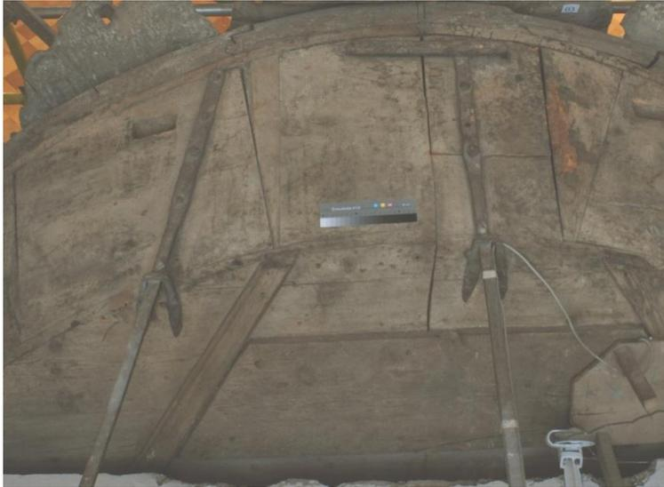
Abb. 79. Nördliches Retabel, Oberseite Baldachin, Wandhaken: Die beiden Schlaudern 2. verhindern das Nach-Vorne-Kippen des Baldachins.
