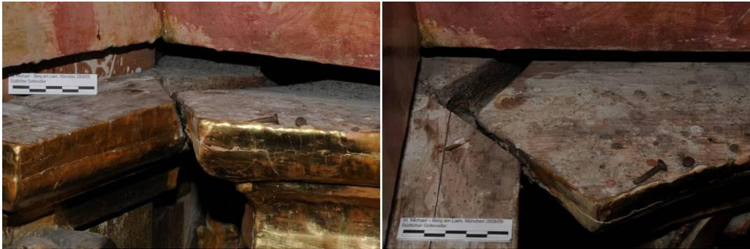
Abb. 45 a/b. Südliches Retabel, östliches Säulenkapitell: Ansicht von Osten auf das angepasste Profil und den Säulenabakus. a) Ansicht von Nordost. b) Aufsicht von Ost.
