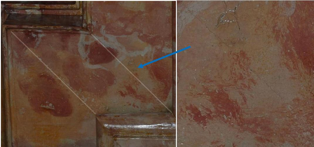
Abb. 48 a/b. Südliches Retabel: Durch die dünnere Schichtstärke zeichnet sich auf der Unterseite der Deckplatte der Kranzgesimse die Vorritzung für die Gehrungsstöße der aufgesetzten großen Kehle und der begleitenden Profile ab.
