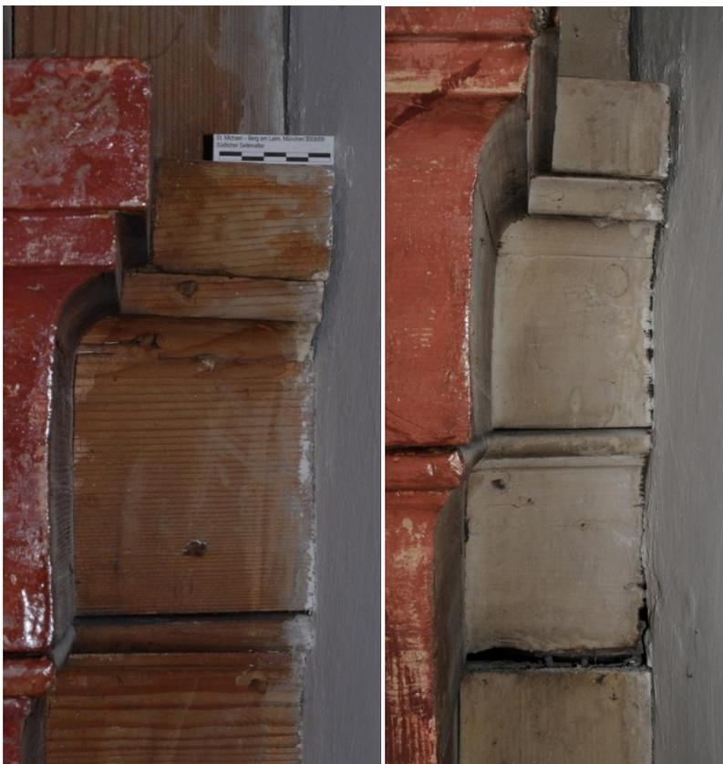
Abb. 51. Rückseitige Verkröpfung der Gebälkstücke am Übergang zur Außenmauer:
