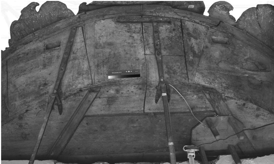
Abb. 41. Nördliches Retabel, Blick auf die Rückseite des Baldachins: Gerader Fugenverlauf zwischen den Baldachinhälften und aus der Achse gerückte Schlaudern. Die Montage der Eisenkrampe erfolgte nach der Befestigung der westlichen Schlauder (die Krampe ist über die Schlauder eingeschlagen). Vermutlich waren die Baldachinhälften zusammengefügt und an der Wand angehängt, erst dann wurde die Krampe zur zusätzlichen Sicherung eingeschlagen.
