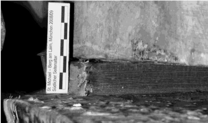
Abb. 27. Südliches Retabel, Ansicht von Westen, Übergang westliches Säulenkapitell – Gebälkstück: Spaltbreite ca. 2 cm. Zur Ausrichtung dienen eingeschobene Holzklötze.
