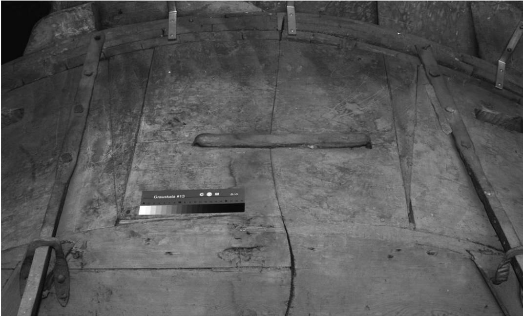
Abb. 42. Südliches Retabel, Blick auf die Rückseite des Baldachins: Geschwungener Fugenverlauf zwischen den Baldachinhälften und symmetrisch montierte Eisenschlaudern. Die unterschiedliche Bretterlage auf der Rückwand zeigt, dass die beiden Hälften getrennt montiert wurden. Der Baldachin wurde also nicht in einem Stück gefertigt und zum Transport auseinander gesägt.
