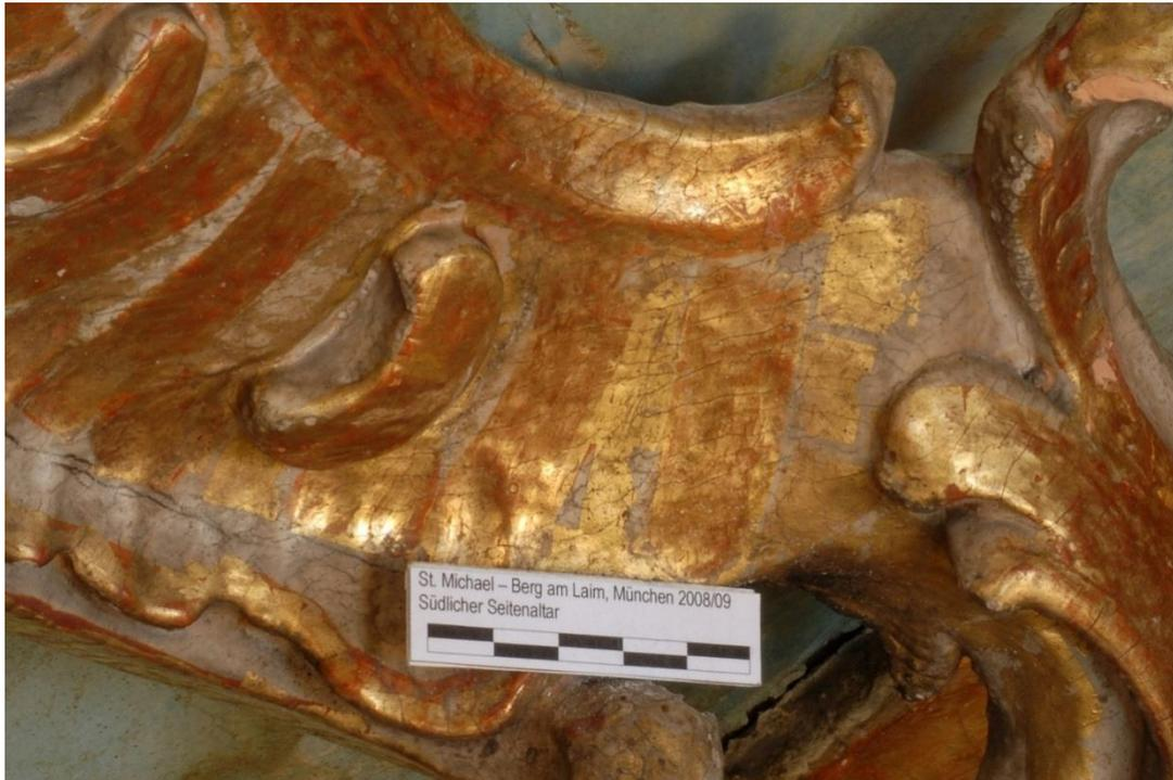
Abb. 55. Südliches Retabel, östliches Ornament im Baldachin: Charakteristisch für die ursprüngliche Blattgoldauflage ist der Wechsel zwischen Matt- und Glanzvergoldung. Häufig erkennt man neben den Glanzvergoldungen Bleistiftspuren Hinweis darauf, dass diese Partien durch Umrisslinien markiert wurden. Auffällig sind die kleinen Blattgoldzuschnitte.
