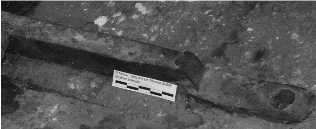
Abb. 32. Nördliches Retabel, östliches Gebälkstück: westliche Eisenschlauder auf der Deckplatte des Kranzgesimses.
