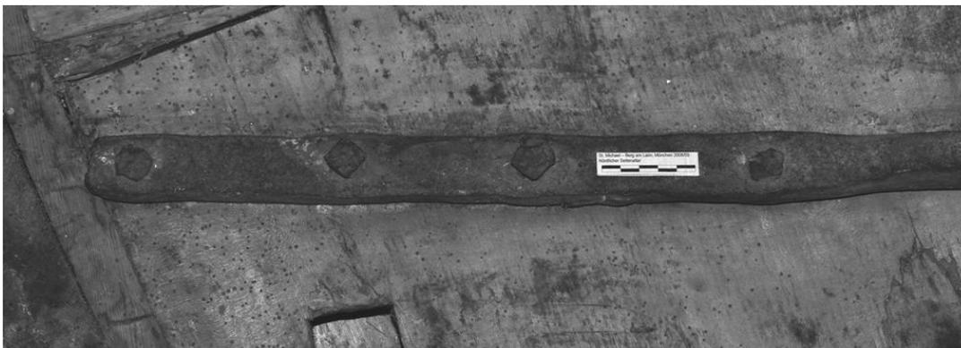
Abb. 33. Nördliches Retabel, Baldachindach: östliche Eisenschlauder.
