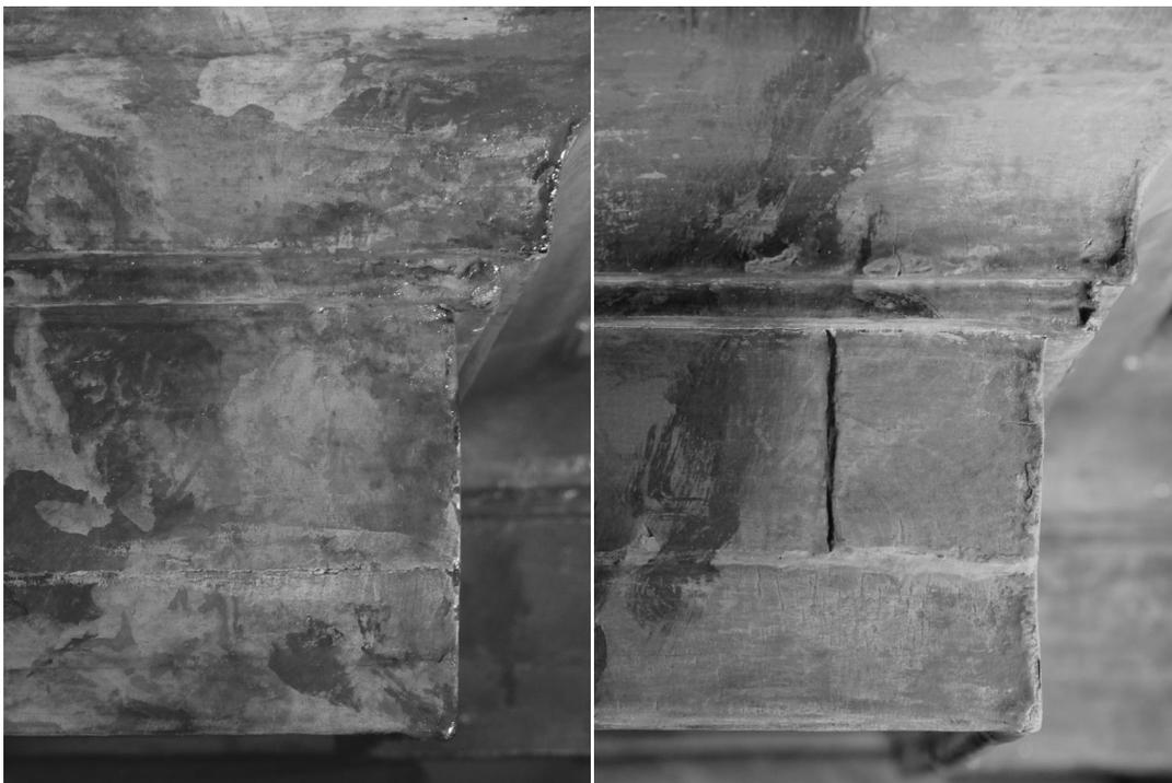
Abb. 46 a/b: Frontansicht, Deckplatte der Kranzgesimse: unterschiedliche Gestaltung der Holzstöße der vergleichbaren Parteien:
