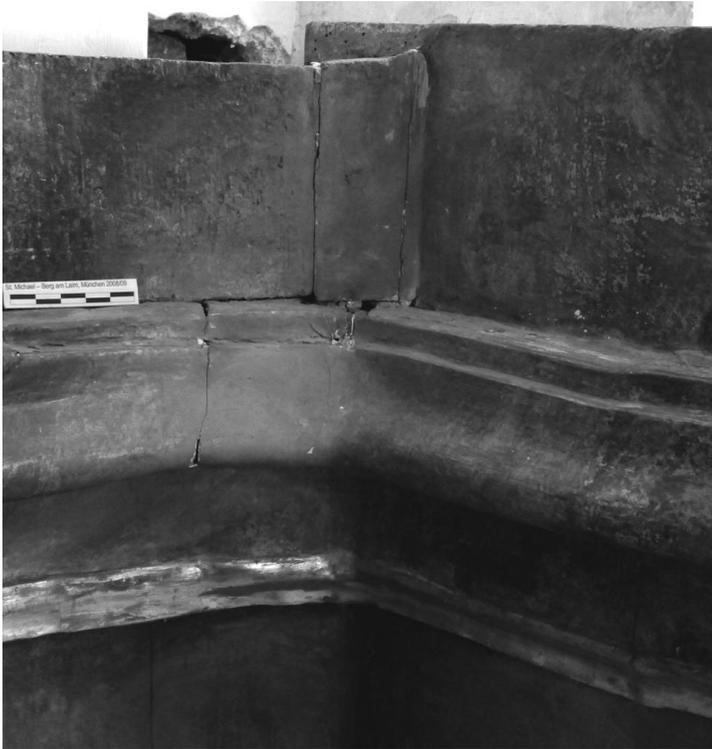
Abb. 9. Nepomuk-Altar/südöstliches Retabel: Übergang gekrümmte Rückwand zur südlichen Konsole. Die Profile verlaufen nicht auf gleicher Höhe, deswegen sind schräge, die Höhendifferenz ausgleichende Profilstücke eingesetzt. Zusätzlich wird die vorgestellte Partie bei der letzten Überfassung mit Grundierung überfasst, dadurch sind die Profile stark verunklärt.
