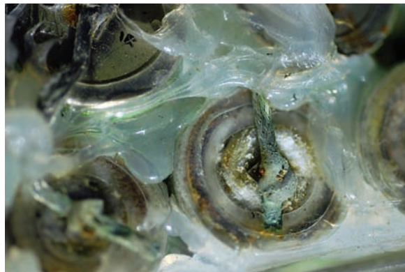
90 Detailaufnahme karbonatisiertes Elektrolyt, grünlich korrodierte Litze, rötliche Korrosion am Stahlbecher
