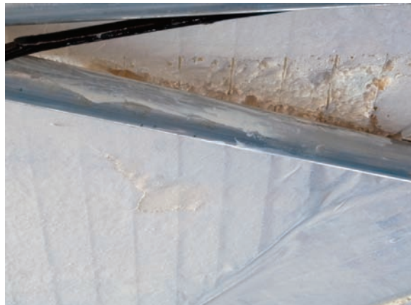
25 Schichtverleimte Styroporplatten, beschichtet und weiß übermalt
