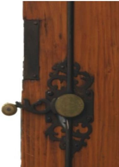
Abb. 78: Schubstangensystem
