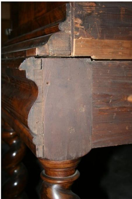
Abb. 132: Zargenkonstruktion Untergestell
