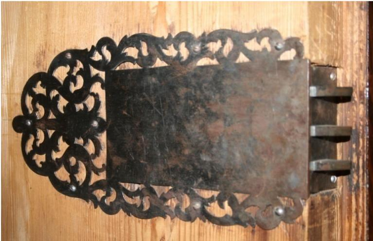
Abb. 110: Altd deutsches Einlassschloss mit polierter Decke
