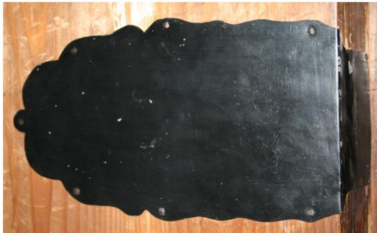
Abb. 44: geschweiftes schwarzlackiertes Blech, in Anlehnung an die ursprüngliche Schlossdecke
