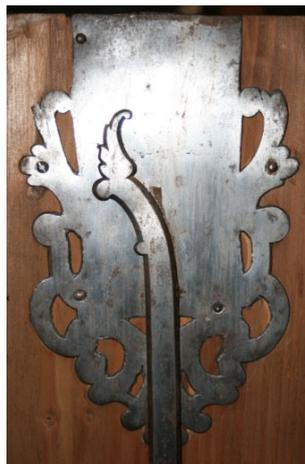
Abb. 53: Riegel und Riegelblech
