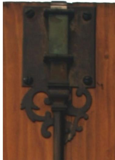
Abb. 79: Riegel und Riegelblech
