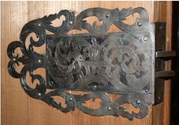
Abb. 100: Altdeutsches Einlassschloss mit geschweifter, gravierter Decke
