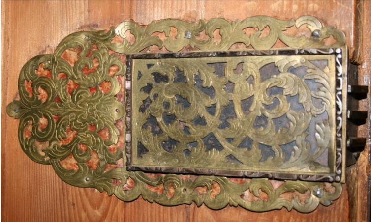
Abb. 92: Altd deutsches Einlassschloss mit geschweifter, graviert er Decke
