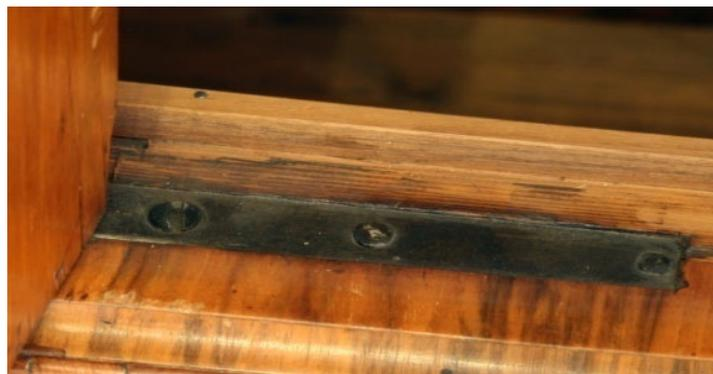
Abb. 76: Zapfenband (L 90 x B 16 mm)
