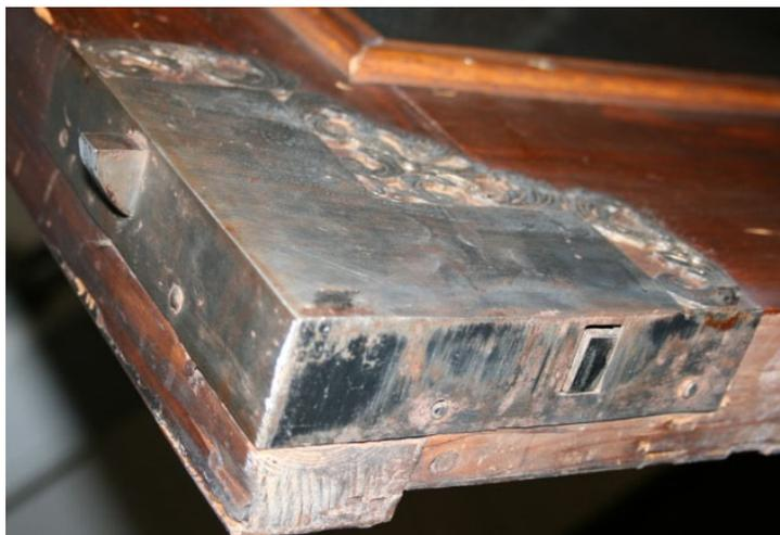
Abb. 65: gravierter Hebelriegel
