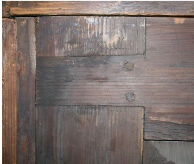
Abb. 97: linke Rückwand, Detail: liegende Gratverbindung
