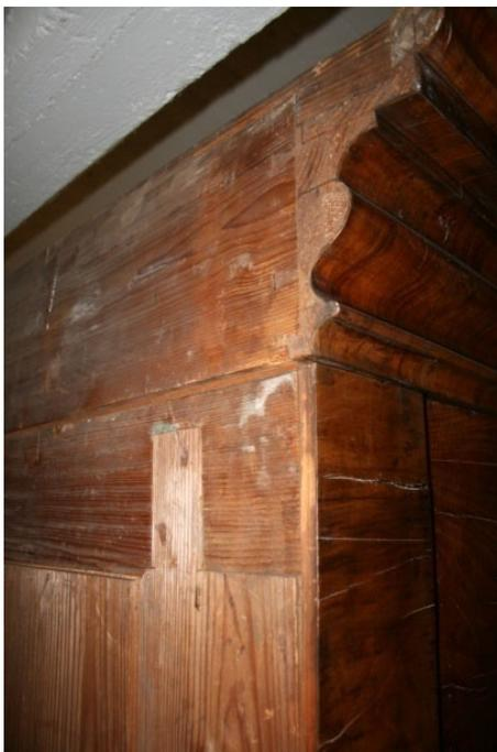
Abb. 125: Konstruktion: Rückwand-Seiten-Gesims
