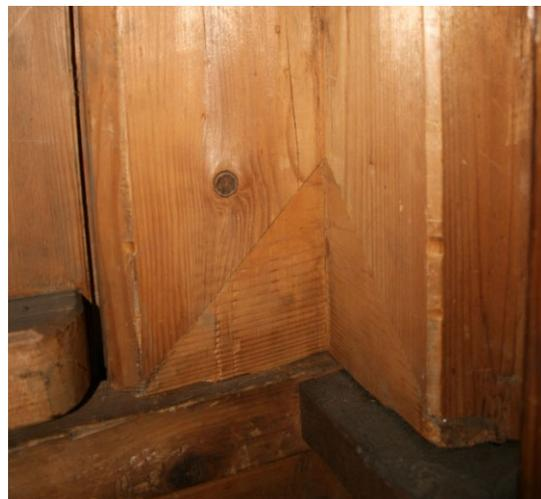
Abb. 107: Grundkonstruktion Ecknase
