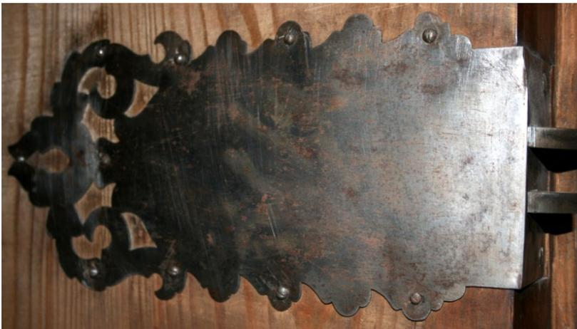
Abb. 120: Altdeutsches Einlassschloss mit polierter Decke
