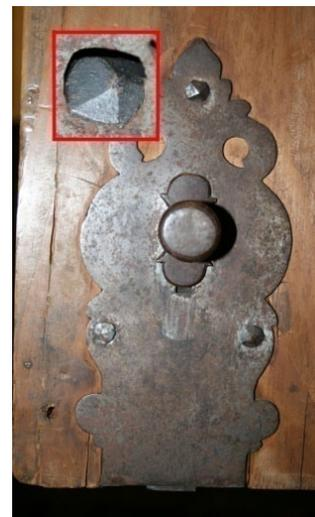
Abb. 72: Riegel/-Blech, Detail: geschmiedeter Nagel
