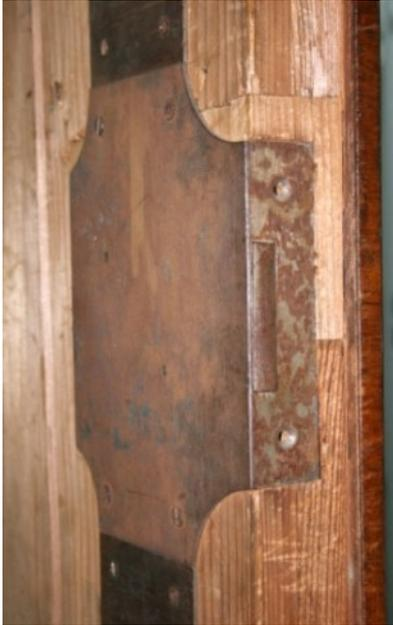
Abb. 86: eingelassenes Schubstangenschloss
