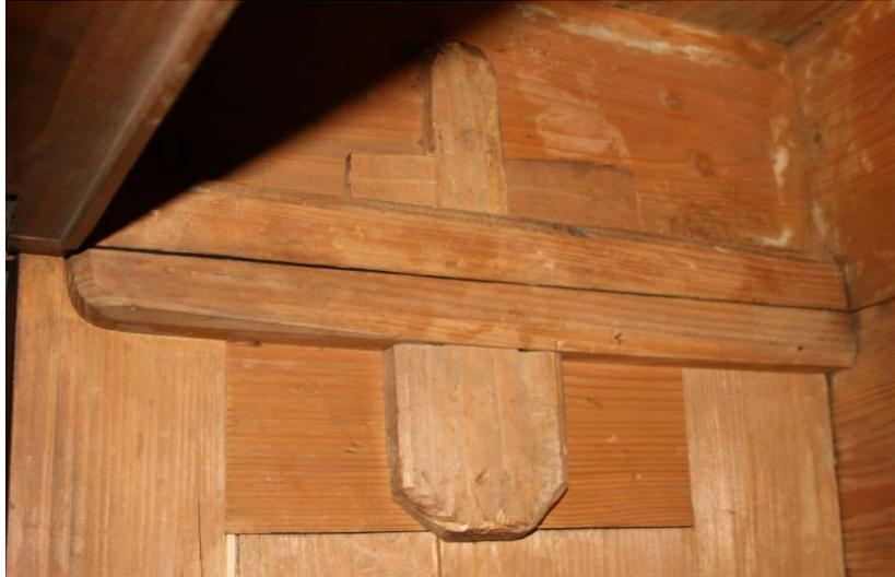
Abb. 134: Verbindung von Deckelkasten mit Seitenteil durch Keilschließe
