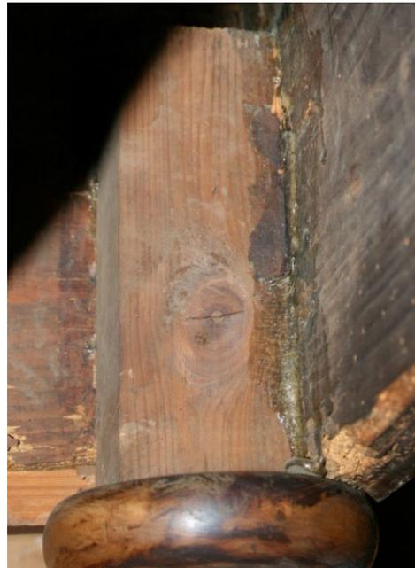
Abb. 130: Detail: eingedübeltes Bein in Kantholz, innerer Eckwinkel Tischzarge
