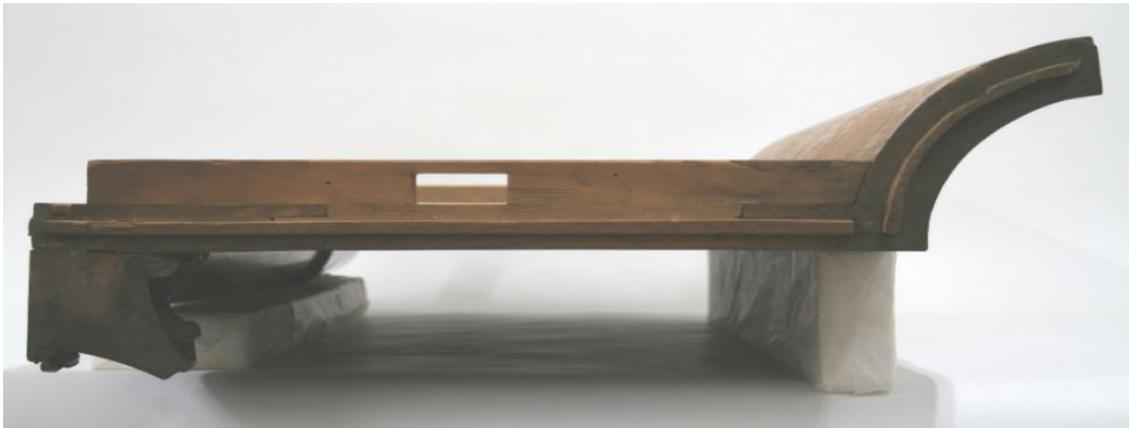
Abb. 17: Säulenschrank hmf X30054, linke Seite: Rahmenkonstruktion mit Nutzapfen, Fremdfeder und ausgearbeitete Lattung für Keilschließe
