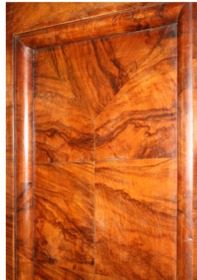
Abb. 63: rechte Seitenfüllung: streng axial gefügte Maserfurnier
