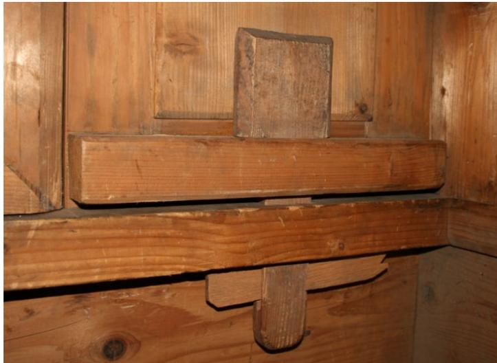
Abb. 108: verbindende Keilschließe: durch überschobene Füllung auf Spannung
