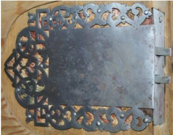
Abb. 38: Einlassschloss mit polierter Schlosdecke, Kleistermarmor in den Durchbrüchen
