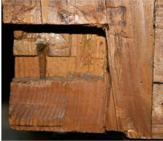
Abb. 45: linke Tür: Aussparungen für Hebelriegel
