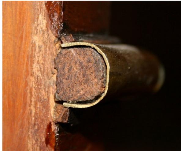
Abb. 70 messingbeschlagenes Profil zur Pilastergliederung, Ansicht von Rückseite
