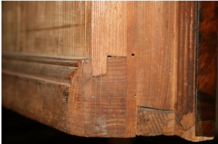
Abb. 105: Detail Tür: eingenetete profilierte Hirnleiste, Rahmendoppel
