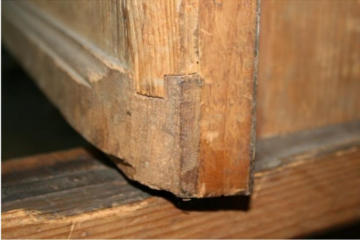
Abb. 82: Detail Tür: eingetutete profilierte Hirnleiste, Rahmendoppel
