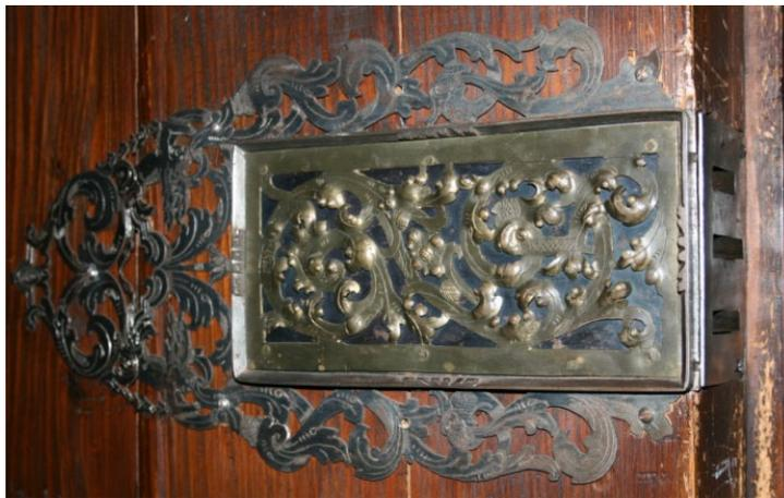
Abb. 64: Einlassschloss mit getriebener, gravierter Schlosdecke
