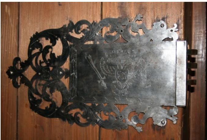
Abb. 57: Einlassschloss mit gravierter Schlossdecke
