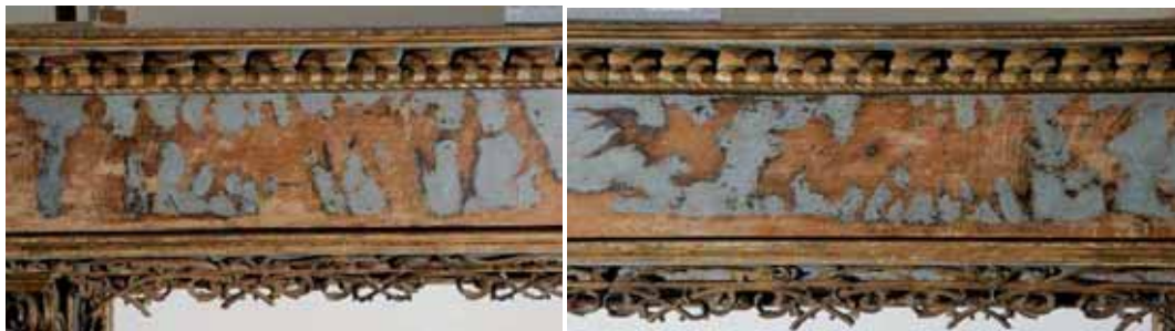
Abb. 133, 134: Gebälk-Ausschnitt nach Demontage des Frieses (links und rechts) mit holzsichtigen, durch den Fries verdeckten Flächen.
