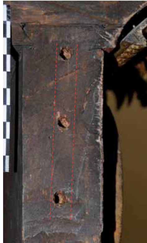
Abb. 149: Gebälk-Kasten, RS, rechte Seitenwand; in einer Linie übereinander angeordnete Löcher einer vermuteten Wandbefestigung.
