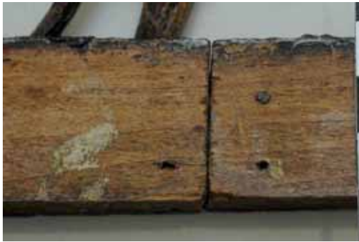
Abb. 174: Stoß der beiden Frieshälften; die durchgehende Maserung beweist, dass der Fries ursprünglich aus einem durchgehenden Brett gefertigt war.
