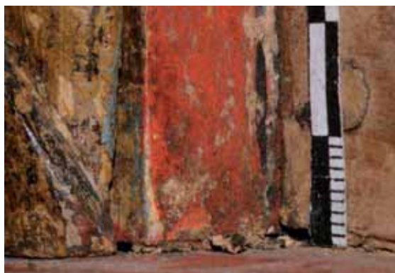
Abb. 81: Gebälk, links; Verlauf der geraden Stöße von Blattleiste, Seitenwand, Fries-Rücklagenbrett und Bodenplatte nach Demontage des Frieses; einer der Holznägel zur Montage des Fries-Rücklagenbrettes halb vom Maßstab verdeckt.
