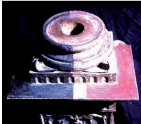
Abb. VII: Basis während der Abnahme des schwarz pigmentierten Überzuges mit Blick auf die Verbindungsart von Basis zu Säulenschaft; die Abbildung zeigt, dass augenscheinlich auf den roten Aufsichten Reste der „steinsichtigen“ Überfassung und/oder der ersten Überfassung (heutige Sichtfassung), die im Zuge der Freilegung von Anfang des Jahrhunderts stehen blieben und den Auftrag des dunklen Überzuges zur Folge hatten, abgenommen wurden.
