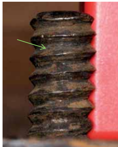
Abb. 94: Gebälk-Kasten, RS, links; Gewinde mit beschädigten Flankenkanten.
