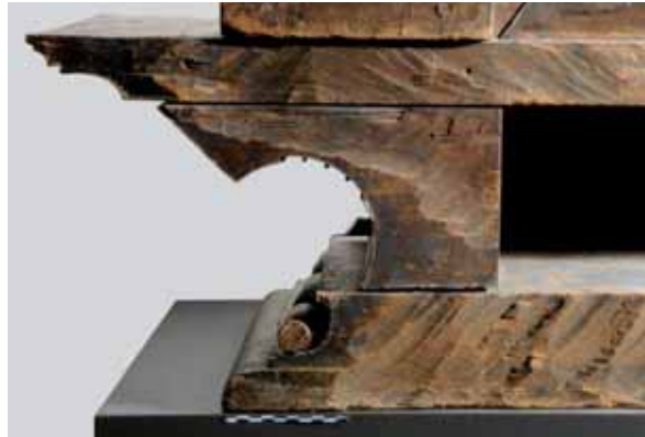
Abb. 107: Predellen-Kasten, RS, links; bebeilte Oberflächen neben glatten zur linken Kante.
