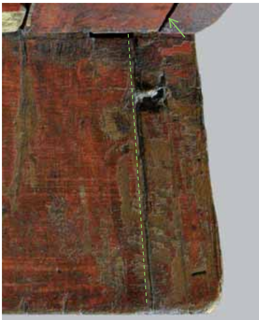
Abb. 147: Predellen-Aufsicht (rechte Seite, Kante Richtung RS); eckiges Nagelloch (Pfeil) und verleimter Bruch (rechts der gestrichelten Markierung).
