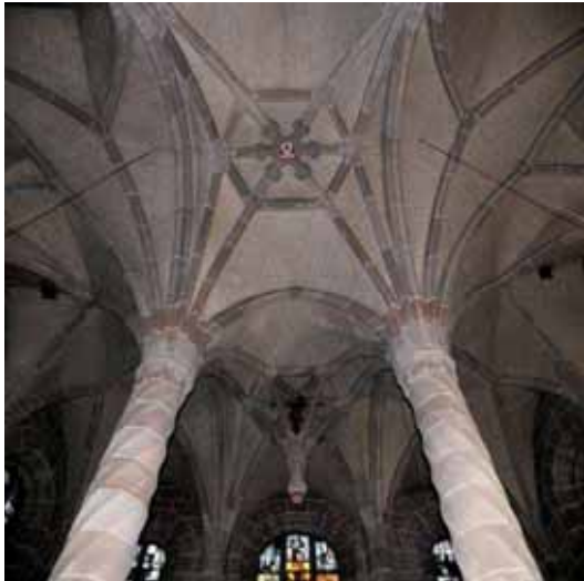
Abb. 21: Ansicht des Gewölbes, 2010.
