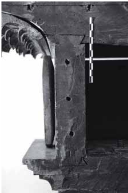
Abb. 75: Gebälk-Kasten, Rückseite, links, Gratverbindung.
