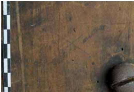
Abb. 124: Hauptgeschoss/Säulenrücklage, RS; X-Markierung.
