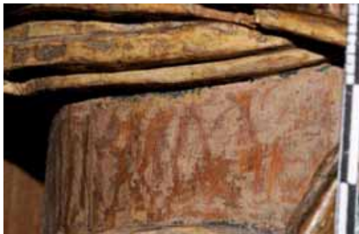
Abb. 154: rechter Säulenschaft (linke Seitenansicht); mechanische Freilegungsspuren bis auf das Holz.
