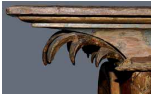
Abb. 48: Oberes Gebälk-Profil (Front, linke Ecke).
