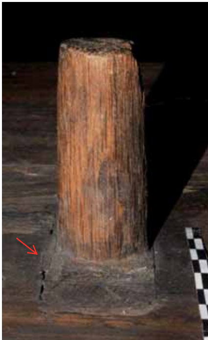
Abb. 83: Gebälk-Aufsicht, RS, rechts; Ansicht des eingekeilten Quaders (Pfeil) und Zapfens; der Zapfen ist aus dem Holz des Quaders gefertigt.
