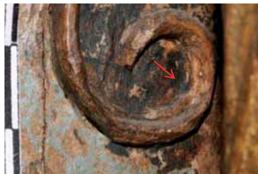
Abb. 139: Säulenschaft der rechten Säule (rechte Seitenansicht); blaue Fassungsreste der ersten Fassung um eine Weinranke (Pfeil); der Farbton wird zum Großteil durch den schwarzen Überzug verfälscht.
