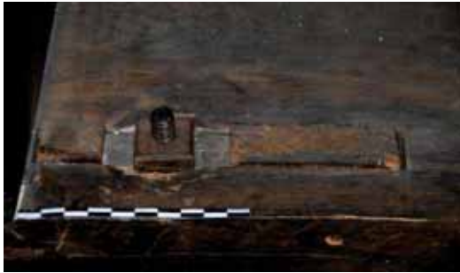
Abb. 95: Innenansicht Gebälk-Kasten, RS, links; Schlitz-Zapfen-Verbindung.
