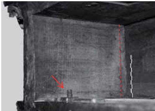
Abb. 77: Gebälk-Kasten, Rückseite (RS), Innenansicht der linken Seitenwand mit eingesetzter Leiste (Stoß rot markiert) zum Brett der Vorderseite; etwas unscharf ist auch die Lage der Schlitz-Zapfenverbindung und der Gewindestange mit Mutter zu erkennen (Pfeil).
