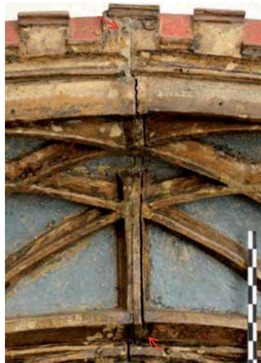
Abb. 165: Lünette (Mitte); Kittung (ggf. Ausspannung) und Retusche des offenen Stoßes (Pfeile).
