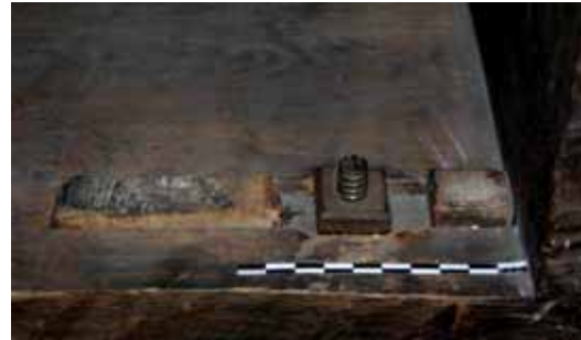
Abb. 96: Innenansicht Gebälk-Kasten, RS, rechts; Schlitz-Zapfen-Verbindung.
