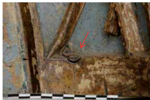
Abb. 88: Lünette, rechts; durch Ausarbeitung der Kehle angeschnittener Holznagel (von vorne eingeschlagen; Pfeil).
