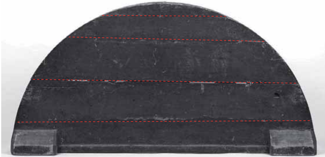
Abb. 84: Lünette, RS; Verlauf der geraden Stöße der fünf Rücklagenbretter mit links und rechts unten aufgenagelten Quadern. Die Stöße sind mit Werk und zu den Quadern vermutlich mit Pergament kaschiert.
