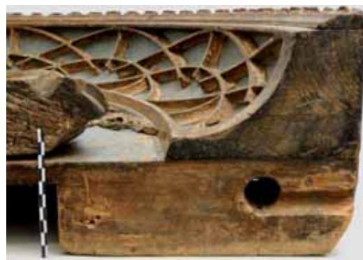
Abb. 86: Unteransicht Lünette, rechts; Profil; der Stoßverlauf entspricht dem von Abb. 64.
