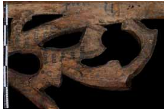
Abb. 175: Schleifenähnliches Ornament an der Gebälk-Unterkante zwischen den Kapitellen; mit Zeitungspapier vor dem Zuschnitt verstärkte Ergänzung.
