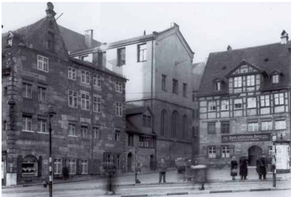
Abb. 11: Blick auf die Kapelle des Realgymnasiums in der Hinteren Landauergasse von 1940 (heute: Innerer Lauferplatz 11); die Kapelle und das Zwölfbrüderhaus wurden im 19. Jahrhundert mehrfach umgebaut und aufgestockt (Foto: StAN, H – 55 - 1).
