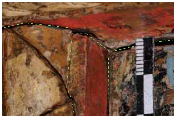
Abb. 80: Gebälk, links; Verlauf der geraden Stöße (grün) von Blattleiste, Seitenwand, Fries-Rücklagenbrett und Deckplatte nach Demontage des Frieses.
