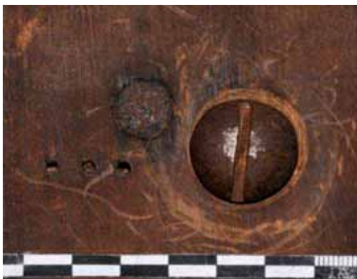
Abb. 97: Hauptgeschoss/Säulenrücklage, RS, links oben; Holzschraube mit Markierung (drei gestanzte Löcher); mittig darüber Eisenstift; der Glanz um die Holzschraube (ebenso in der folgenden Abbildung) lässt auf eine verdichtete Oberfläche durch eine Unterlegscheibe schließen, die sich vermutlich bis zum Nachschneiden der Gewinde zwischen Holz und Schraubenkopf befanden; für einen verbesserten Halt der nachgeschnittenen Schrauben wurden die Unterlegscheiben wahrscheinlich weggelassen.
