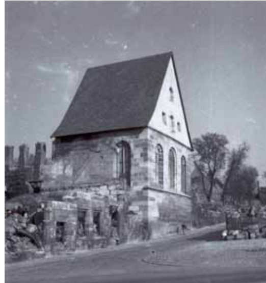
Abb. 13: Ansicht der Kapelle, 1950, nach Sicherungsmaßnahmen: Hochziehen des Mauerwerks, Errichtung eines Satteldachs, Verglasung der Fenster (Foto: StAN, A39 – Fi - L - 456).
