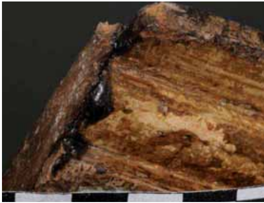
Abb. 148: Gebälk, Hauptprofil (linke Seitenansicht, linke Ecke); Nasen verbräunter Leimreste.
