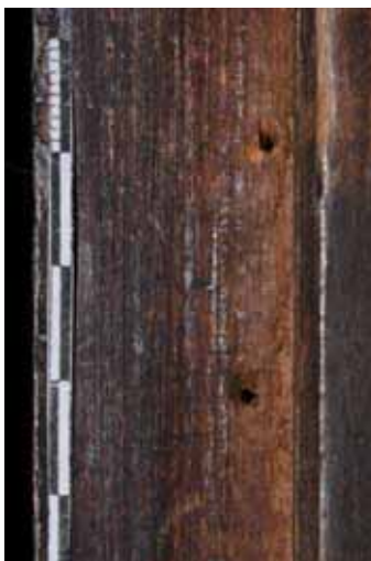
Abb. 172: Falz (RS der linken Säulenrücklage); milchige Leimreste mit Gewebeabdruck und Nagellöcher.
