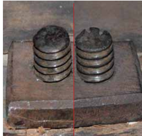
Abb. 92: Muttern und Gewindestangen im Gebälk-Kasten (Aufsicht auf Bodenplatte; Fotomontage).
