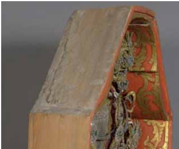
Abb. 348: Dachaußenseite mit Wasserflecken
