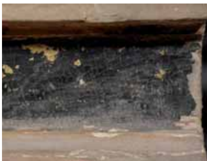
Abb. 602: gelüsterter Bodenplatte, Gehäuse mit hl. Haupt, VZ
