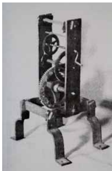
Abb. 286: „Radl“ zum Zacken von Lahn, Reutberg 18. Jh.
