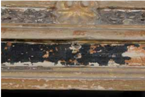
Abb. 546 (o.): Bodenplatte mit Abplatzungen, Craquelé und Verschmutzungen in den Tiefen
