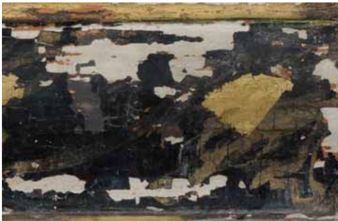
Abb. 467: Sims im Dachbereich, linke Seite, vergrünter Lüster mit goldener Äderung
