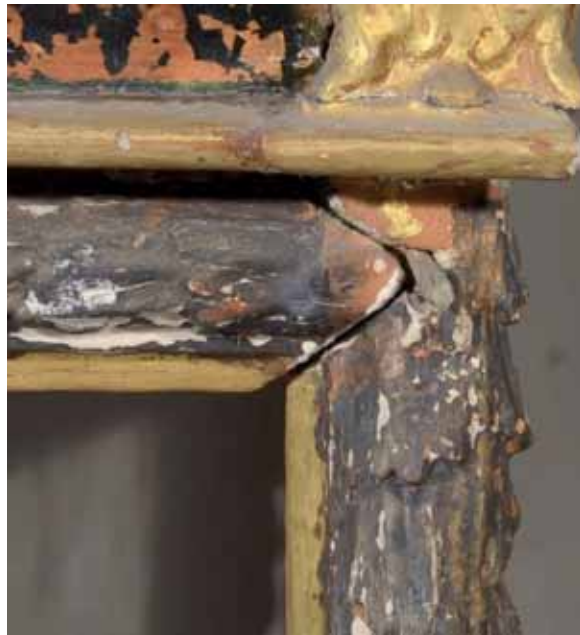
Abb. 456: überplattete Gehrung
