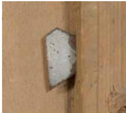
Abb. 340 (li.): Aufsatz, Rückseite mit Wasserflecken
