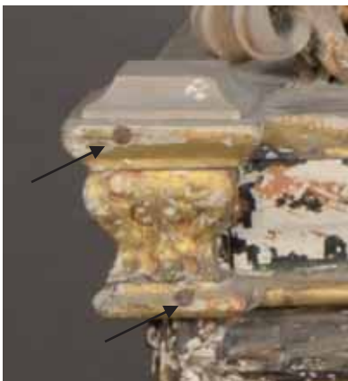
Abb. 540: korrodierte Nägel
