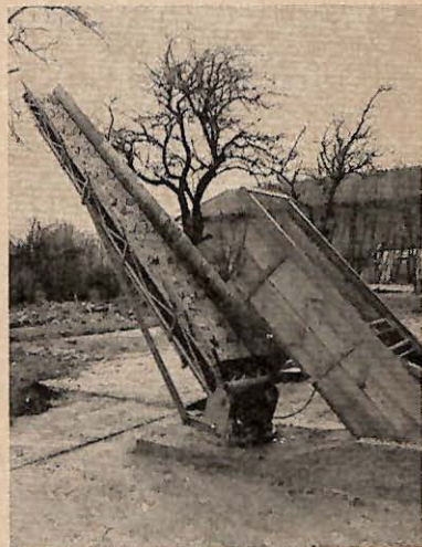
Abb. 3. Kleinhochförderer mit seitlich schwenkbarem Dungverteiler
