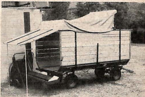
„Haas“-Feldhäcksler-Wagenaufbau (mit dahinter angeordnetem Abladegebläse)
