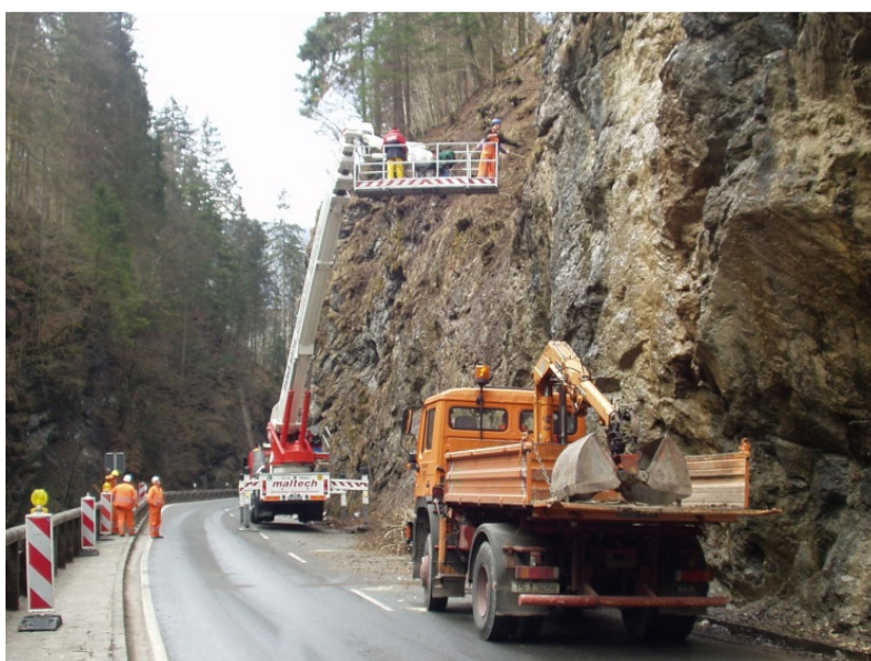
Abb. 70: Jährliche Felsberäumungsarbeiten durch die Straßenmeisterei Bischofswiesen (B 305, StBA TS - Bildarchiv)
