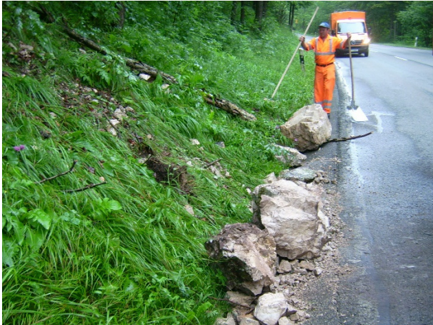
Abb. 68: Beseitigung eines Steinschlagereignisses durch die Straßenmeisterei Bischofswiesen im Zuge der B21
