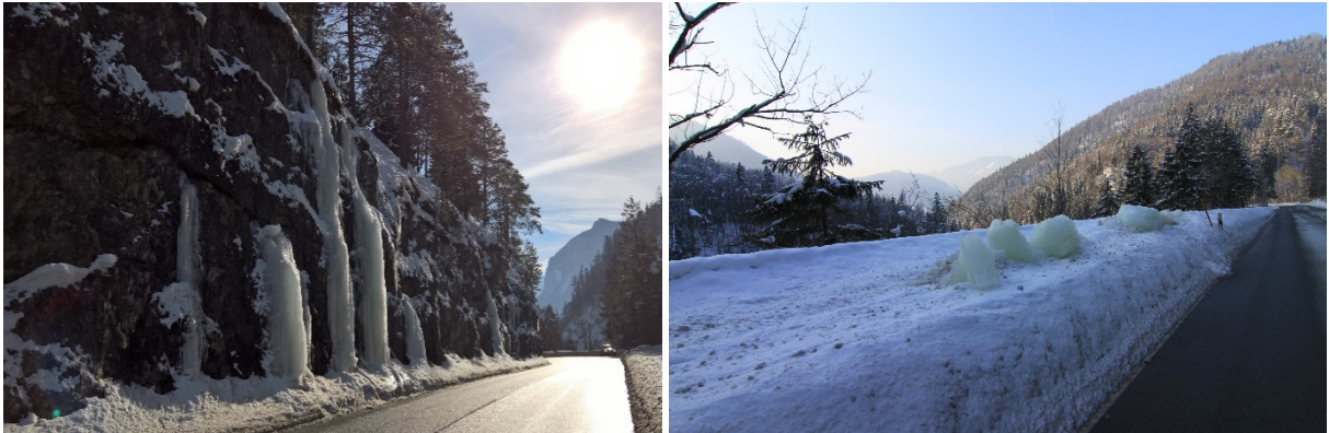
Abb. 23 u. 24: Eissturzdokumentation an der B305 zwischen Weißbach und Schneizlreuth im Winter 2014/15
