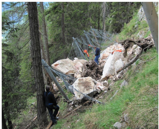
Abb. 79: Von Lawinennetz zurückgehaltener Steinschlag
