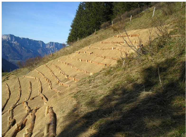
Abb. 116: Ingenieurbioologische Sicherung des Hanganbruchs - Rossfeldstraße
