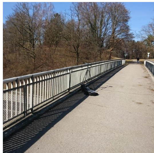
Messaufbau auf Brücke
