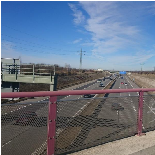
Blick Richtung Norden
