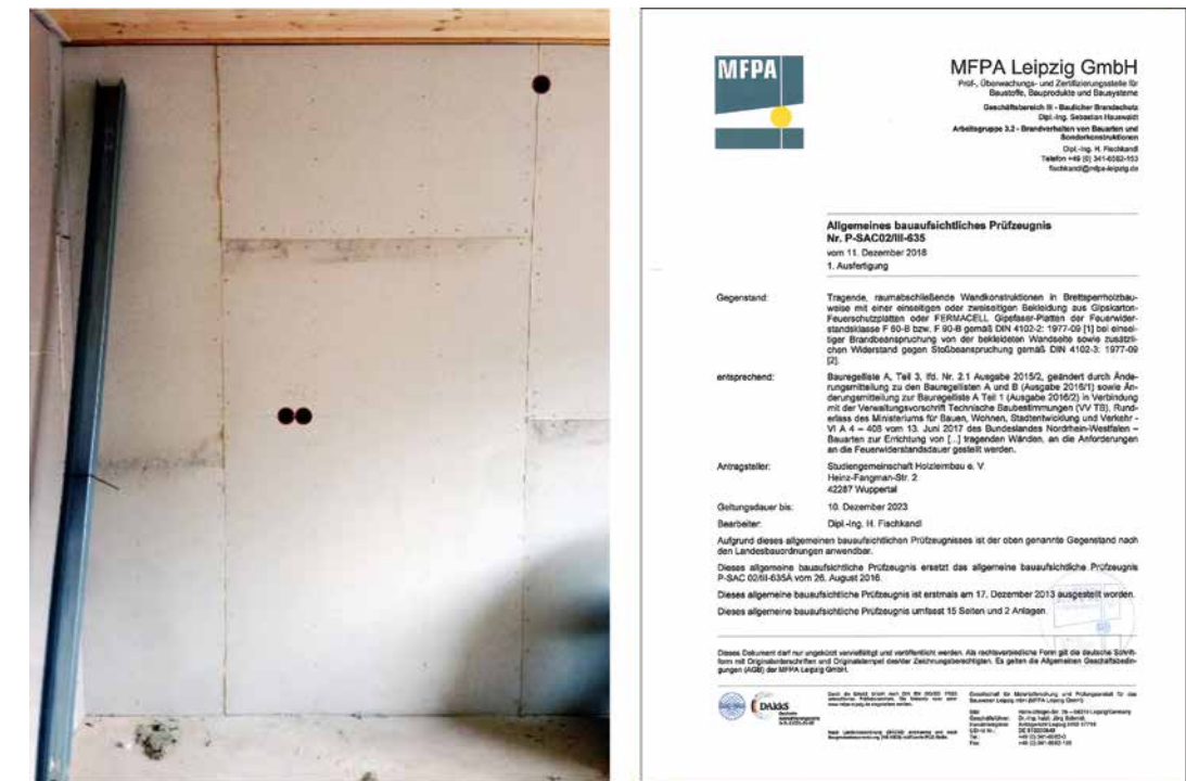
Abbildung 20 Wand zur Brandabschnittsbildung in Gebäudeklasse 3 in Brettsperrholzbauweise
