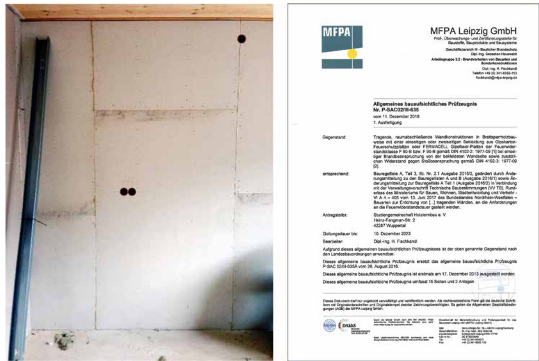
Abbildung 20 Wand zur Brandabschnittsbildung in Gebäudeklasse 3 in Brettsperrholzbauweise
