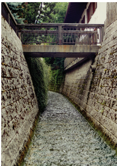
Abb. 8: Wildbachverbauung in Bad Oberdorf aus dem Jahr 1978
