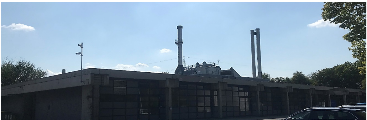
Abbildung 12: Technische Zentrale: Büro- & Werkstattgebäude des TUM Referats 45 - Gebäudemanagement Campus Garching mit dahinterliegendem Heizkraftwerk
