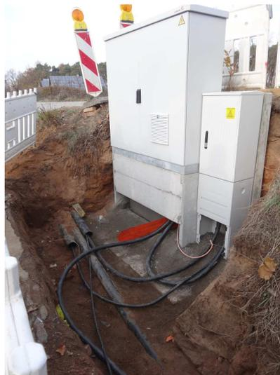
Abbildung II-81: Längsregler-Einbau im Feldtestgebiet
