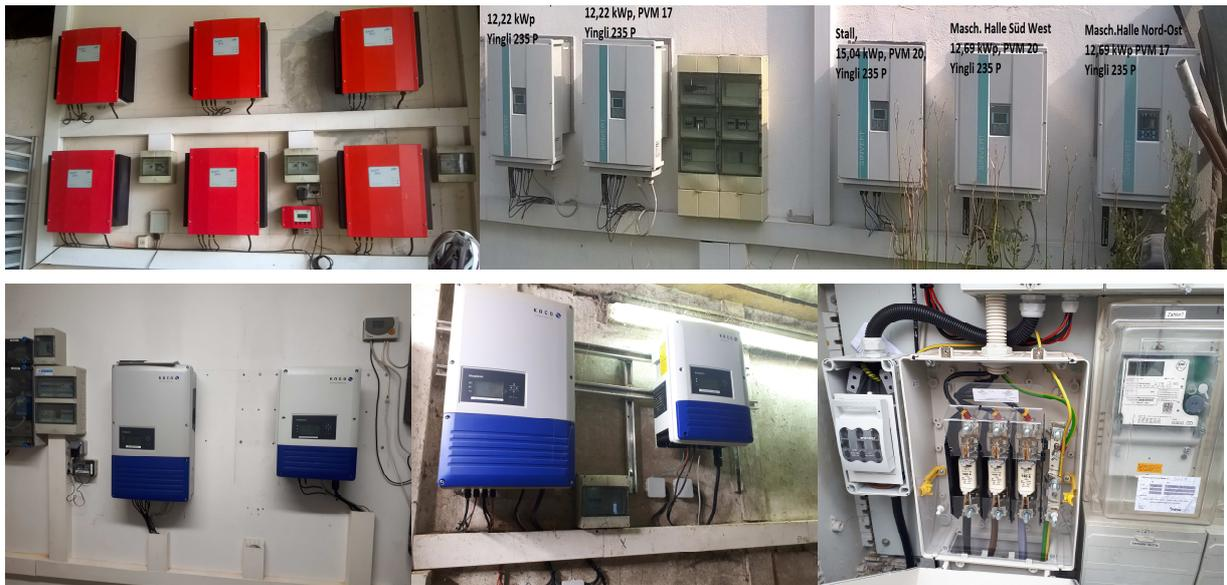
Abbildung II-79: Einbau aktiv regelbare PV-Wechselrichter (oben: Altgeräte; unten: Neuinstallation)
