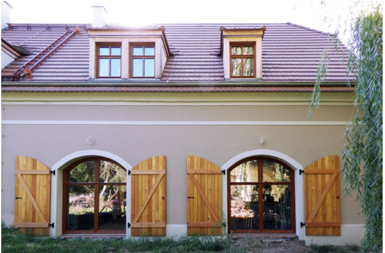
Abb. 2.2–2.6: Wohnstallhaus in Spree – nach der Sanierung | Quelle: Malischke
