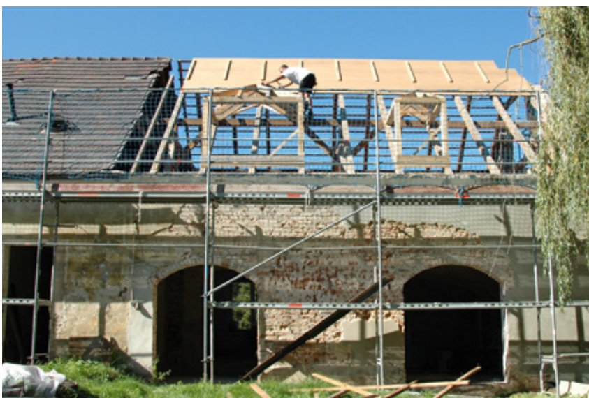
Abb. 2.1: Wohnstallhaus in Spree – während der Sanierung Quelle: Malischke
