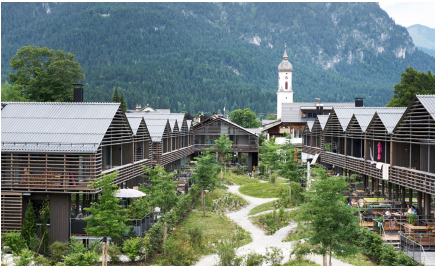
Abb. 1: Altes Garmisch neu gelebt – Markt, Garmisch-Partenkirchen Architektur: Beer Bembé Dellinger Architekten und Stadtplaner, Greifenberg Foto: Stefan Müller-Naumann, München
