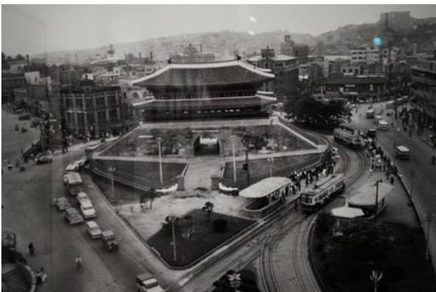
Abb. 25: Blick auf dem Tor bei der Konstruktion im Jahr 1963
