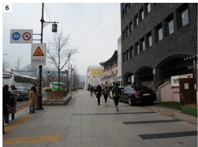
Abb. 45: Blick zur rekonstruierten Straße und Fußweg
