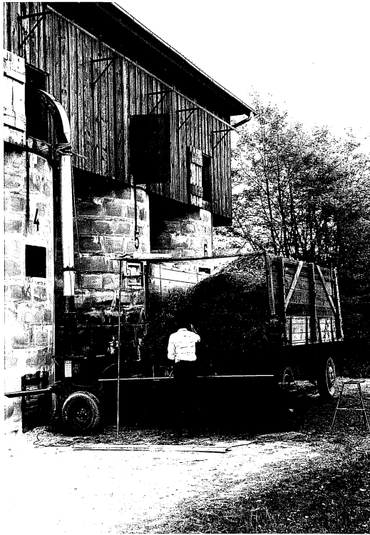
Annahmegebläse und mechanische Wagen- entleerung nach hinten.
