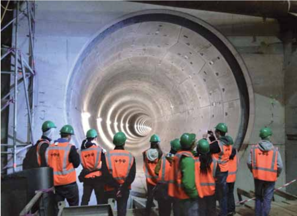
Bild 3: Tunnelbau mit Tübbings in der Station Vijzelgracht
