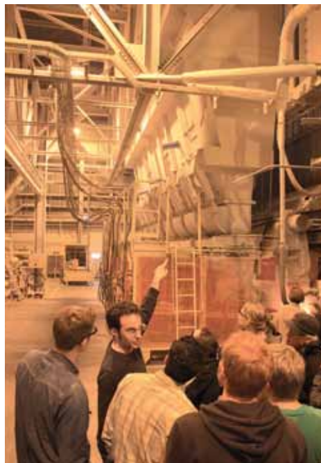
Bild 10: Floatglasherstellungsanlage von Guardian Industries in Luxemburg
