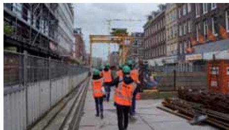
Bild 1, li.: Station Ceintuurbaan Bild 2, re.: Station Vijzelgracht
