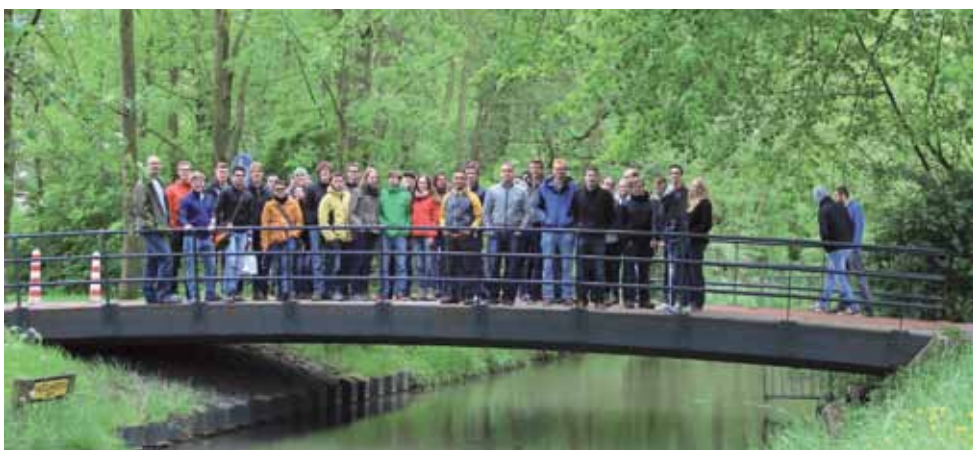
Bild 7: Fußgängerbrücke in Lunetten
