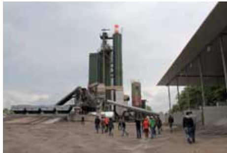
Bild 13: Mischwerk des Asphaltmischwerks
