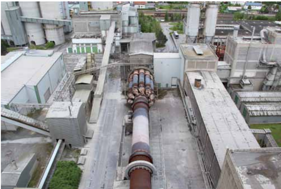
Bild 16: Horizontaler Lepolofen und Satellitenkühler
