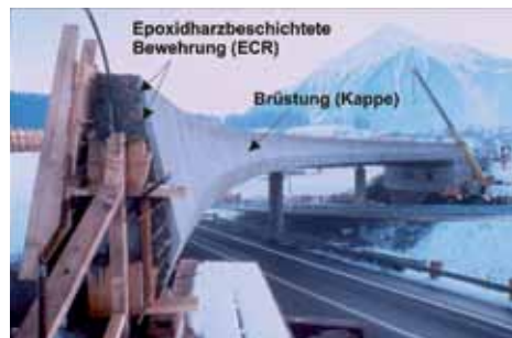
Bild 9: Außenansicht der Brücke in Spiez im Bauzustand 1988.
