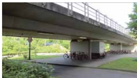
Bild 6 Außenansicht der Brücke Schießbergstraße in Leverkusen im Jahr 2012
