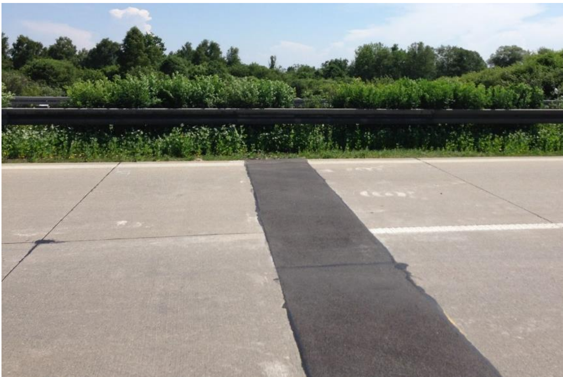
Bild 4.11: In halbseitiger Bauweise hergestellter Asphaltentlastungsstreifen in der Betondecke
