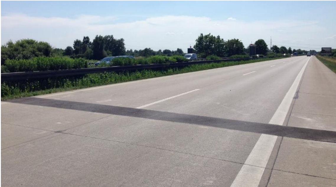
Bild 4.10: Asphaltentlastungsstreifen in einer Betonfahrbahn
