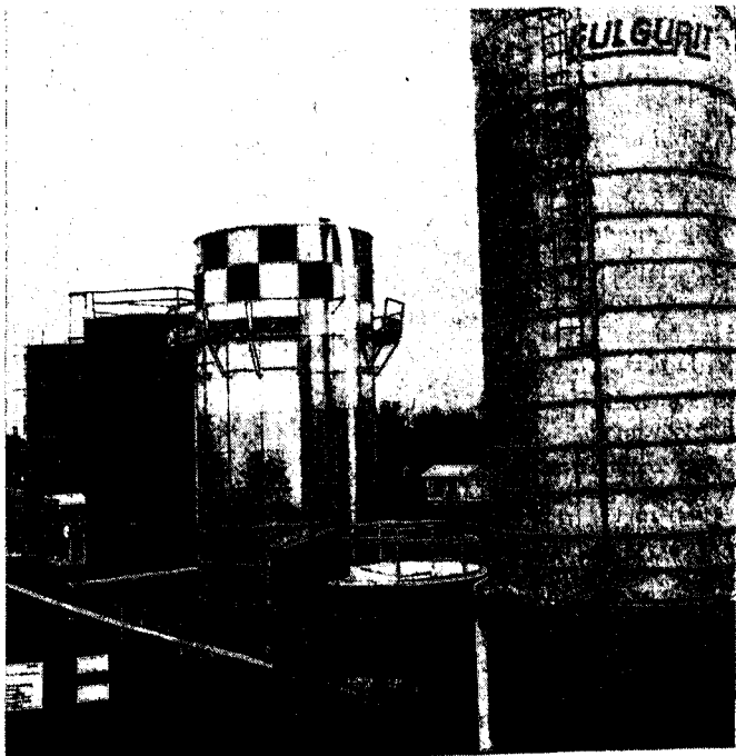
Abb. 3: Hochsilos der ALB-Musterschau. Vorn ein Silo für Untenentnahme. Alle anderen Behälter sind für Obenentnahme eingerichtet. Folgende Baustoffe zeigt das Bild: Asbestzement, Beton, verzinktes Stahlblech, Keramik, Holz
