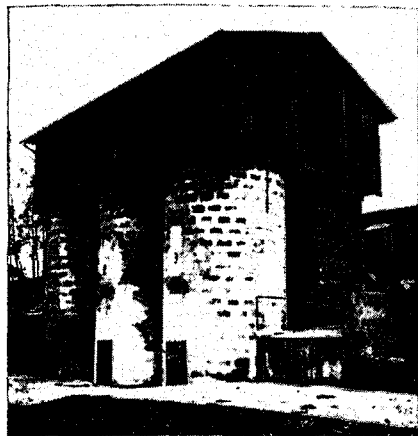
Abb. 4: Umgebaute Sechs-Silo-Batterie mit 600 cbm Inhalt
