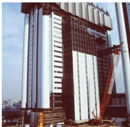
Produktion eines Gebäudes aus Modulen auf der Baustelle in Japan: automatisierte Hochbaustelle.
