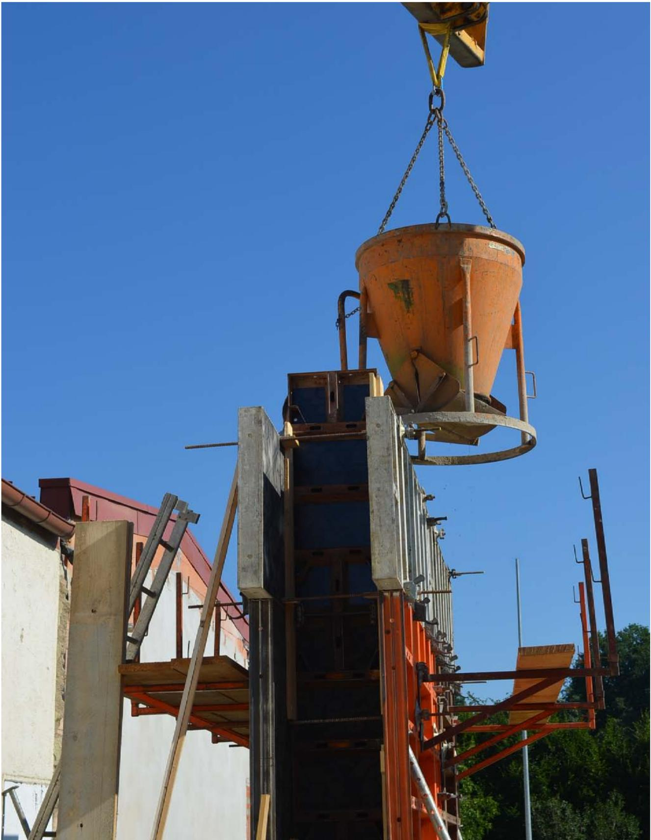
Betoniervorgang Leichtbetonwand mit Kübel, da Infralichtbeton nicht pumpfähig ist
