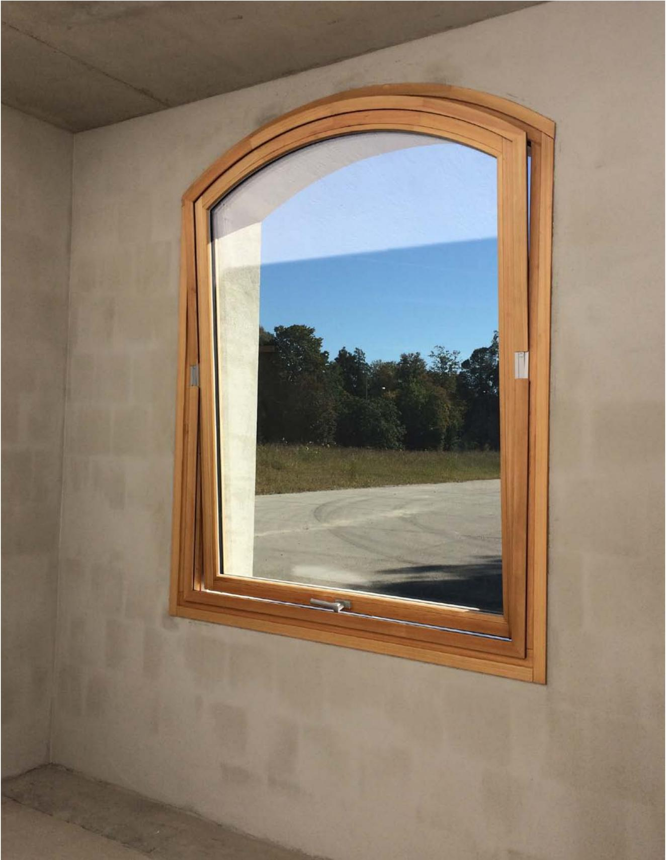
Mauerwerk: Lüftungsstellung Schwingflügel
