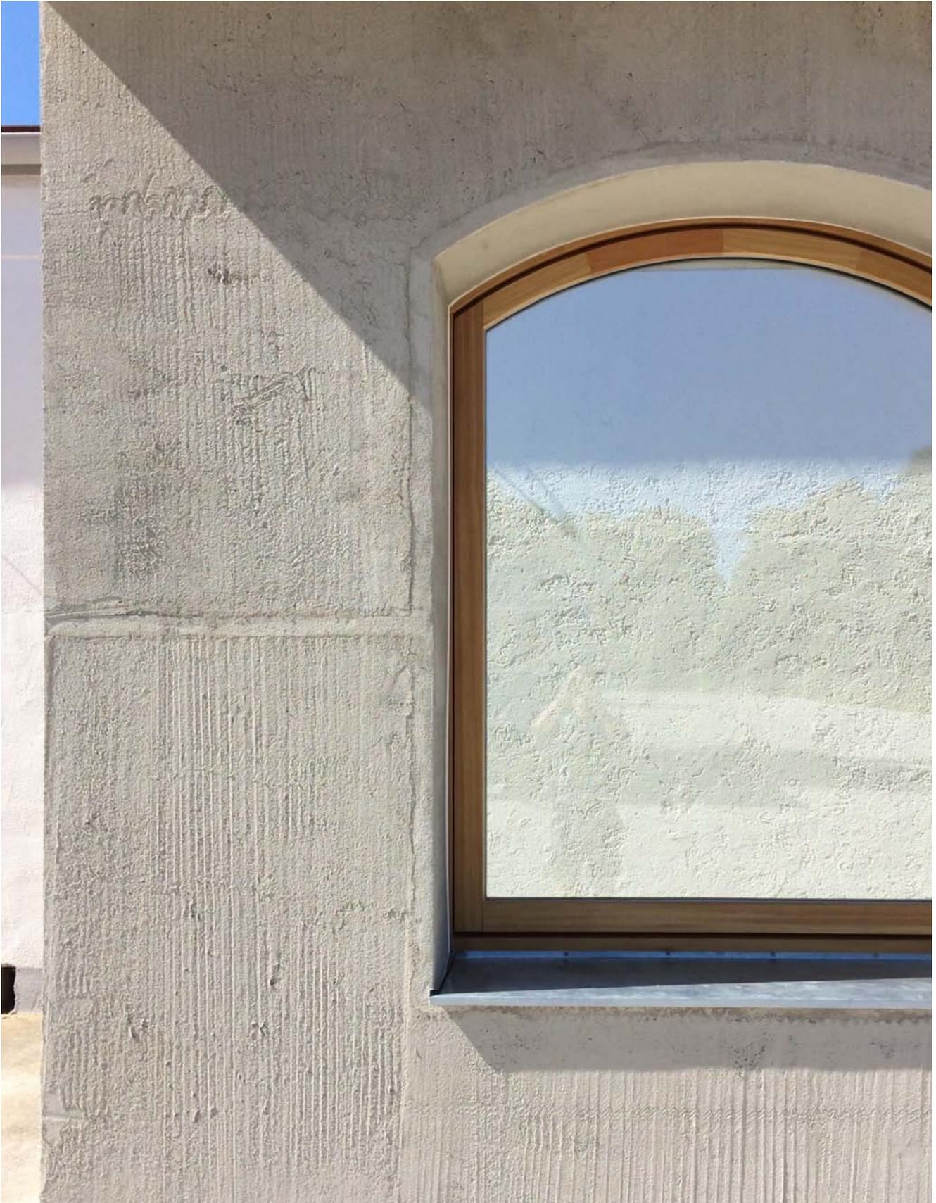
Außenwand Mauerwerk mit aufgebracht Putzschicht
