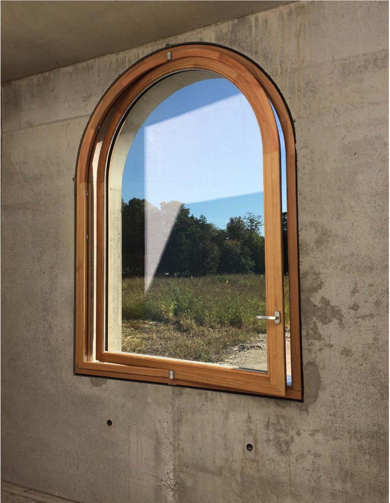
Infraleichtbeton: Lüftungsstellung Wendeflügel
