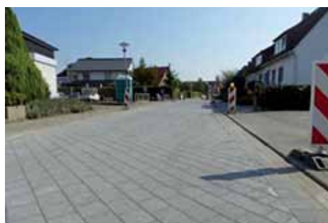
Bild 2: Einsatz der offenporigen Betonpflastersteinen in einer öffentlichen Verkehrsfläche (Foto: SF Kooperation, Bremen)
