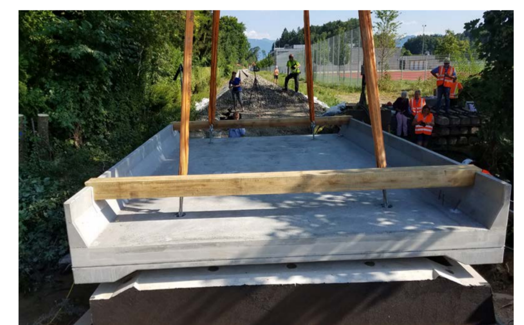
Einbau des Brückenfertigteils
