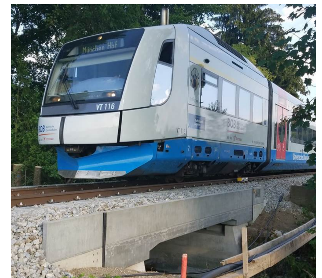
Inbetriebnahme der neuen EÜ Dürnbach
