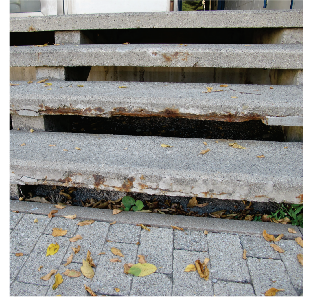
Abbildung 1: Eingangstreppe aus Stahlbeton, korrodierend
