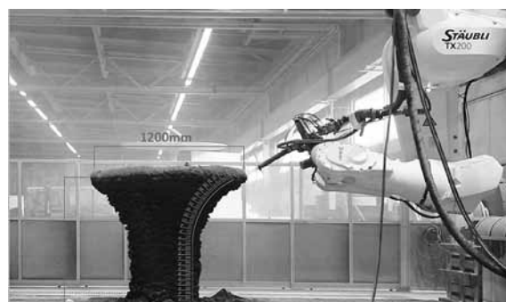
Abbildung 9: Shotcrete 3D Printing mit graduell gedrehten Schichten [12]
