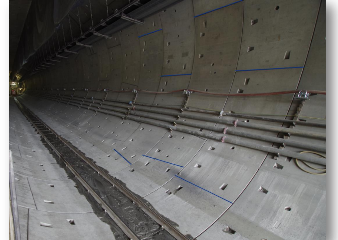
links: Tübbing in der Produktion mit Blick auf die Tübbinglängsfuge; rechts: Tübbingtunnel im einschaligen Ausbau (Längsfugen blau nachgezeichnet)
