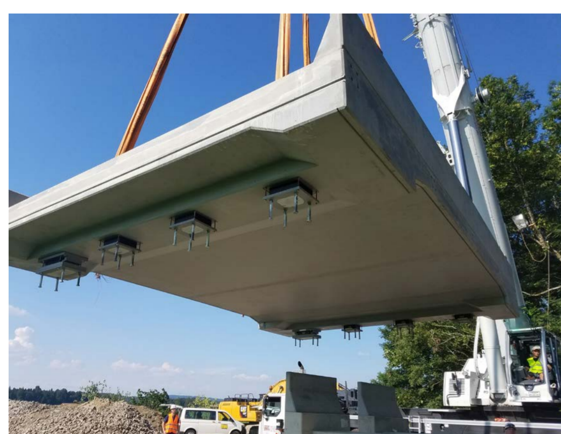
Einheben des lediglich ca. 21 t schweren Brücken-Fertigteils
