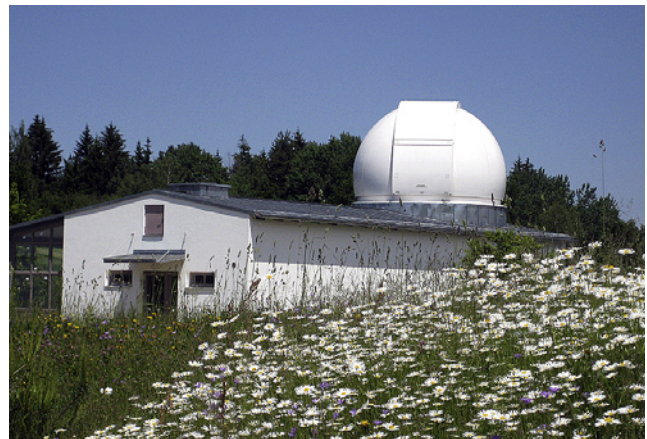
Abb. 9: Betriebshaus des neuen Lasermesssystems SOS_W
