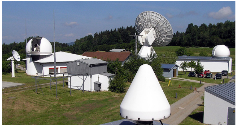
Abb. 3: Fundamentalstation Wettzell: im Vordergrund eine GNSS-Antenne, im Hintergrund von links WLRs, RTW und das Gebäude des neuen SOS_W
