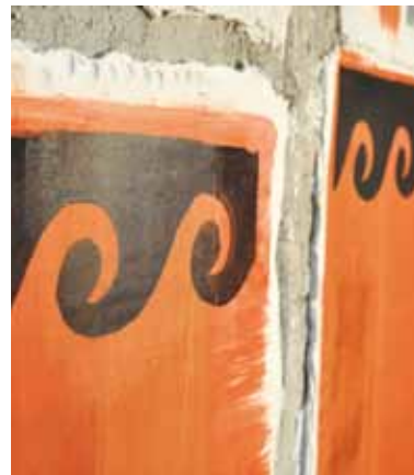
Probeflächen zur freskalen antiken Glättputztechnik Plots for ancient technique of fair faced plaster
