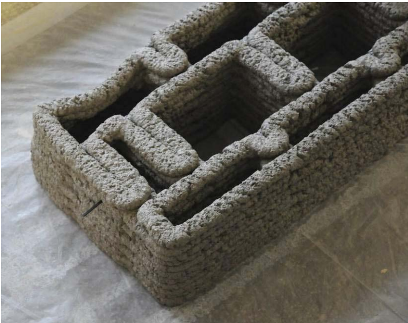
Abbildung 58: Bau eines Testobjektes mit Schichtgeometrie D, Wegkippen eines der ungehaltenen Abschnitte der einspurigen Außenscheibe nach 12 Schichten
