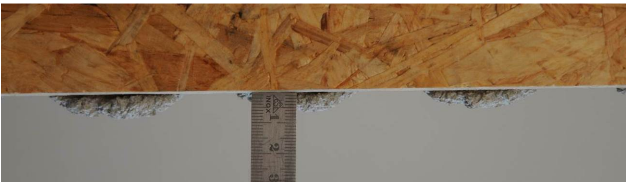
Abbildung 46: Überhangversuch I, Untersicht, Detail Schlaufe Nr. 5 mit einem Überstand von 7 mm
