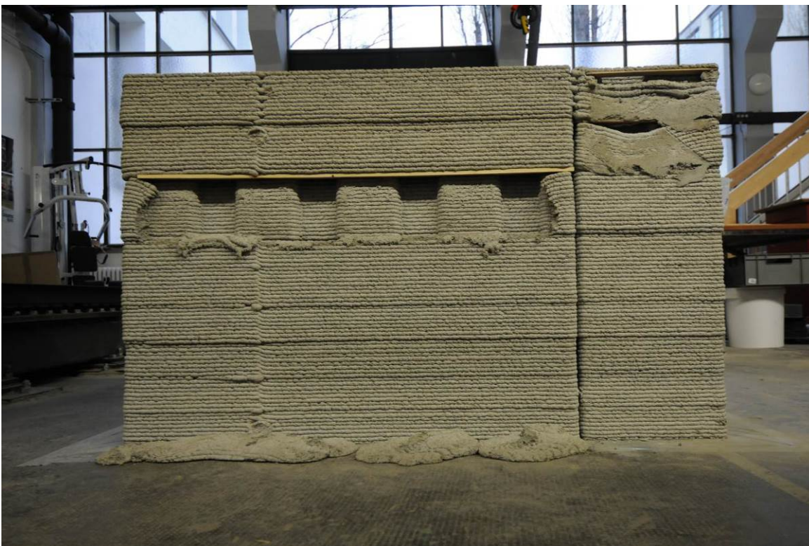
Abbildung 56: Rückseite der Testwand mit Ausbrüchen
