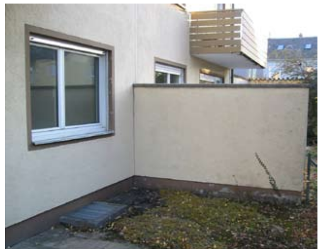
21. Window and light shaft, DH Weissenseestraße, Augsburg
