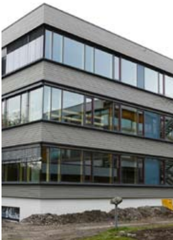
192. Façades after modernisation
