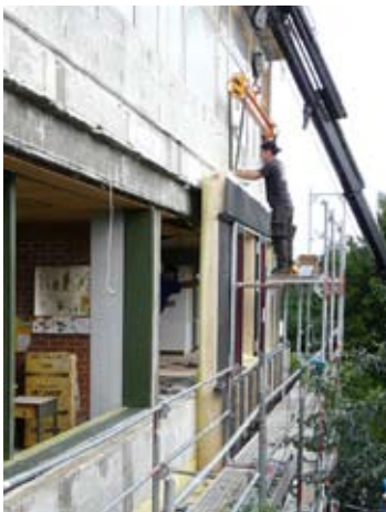
182. Assembly of TES element.
