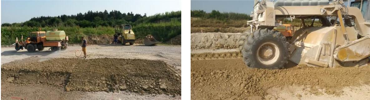
**Abb. 5.9:** Wasserzugabe zum leicht plastischen Ton und Einfräsen des zugegebenen Wassers mit 2 Fräsdurchgängen
