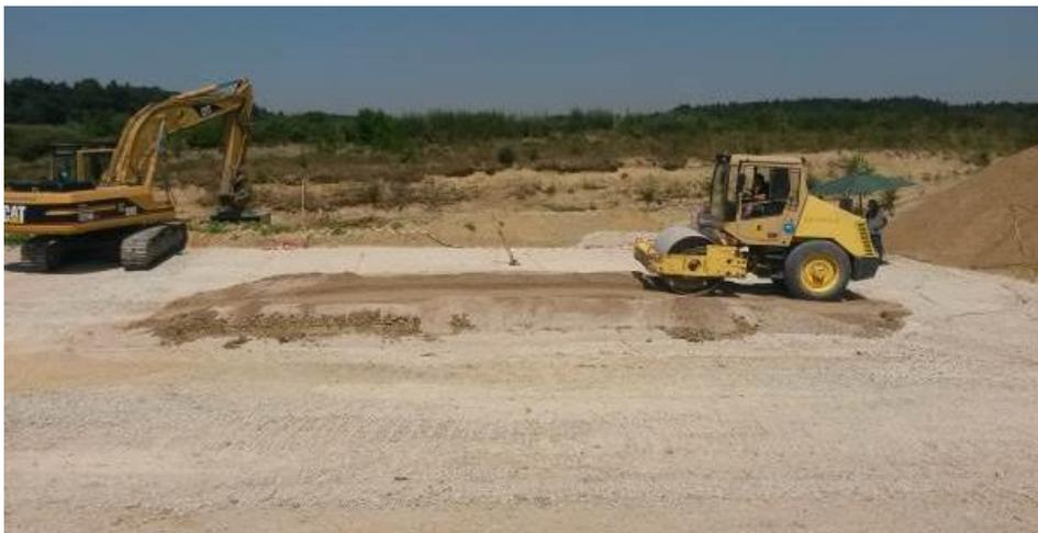
**Abb. 5.6:** Verdichtung des gefrästen Schichtpaketes
