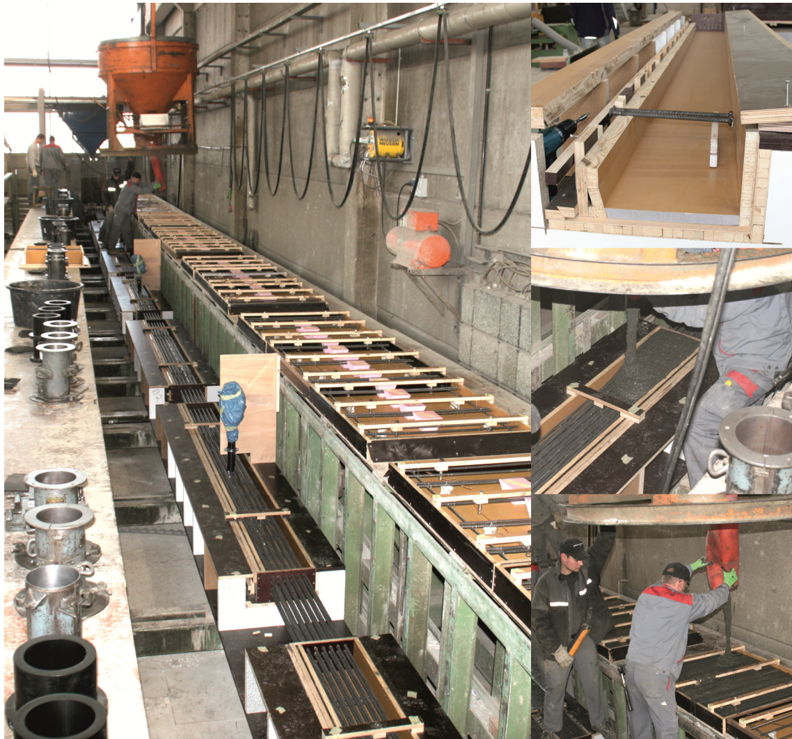
Bild 7.12: Schalung und Betonage der Fügeile der Plattenbalken
