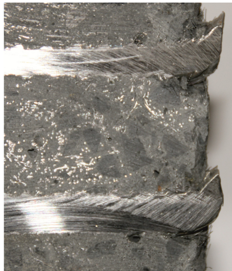
Bild 5.26: Sägeschnitt durch im UHPC-Steg eingebettete Bewehrungsstäbe des VK 8.2b
