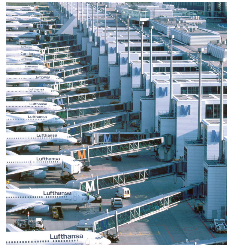
Abb. 4.7 Hohe Auslastung - Fluggastbrücken am Terminal 2
