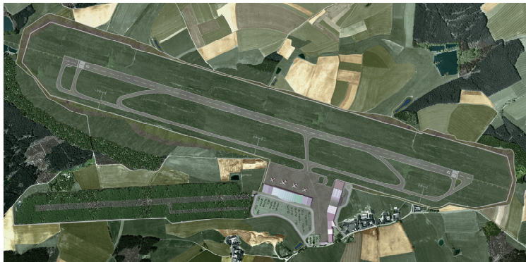
Abb. 7.9 Alte und neue Startbahn
