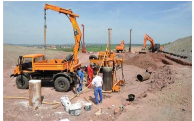
Abb. 5: NBS Ebensfeld – Erfurt, Voreinschnitt Nord Tunnel Lichtenholz (Fotos:ARCADIS/DB AG)
