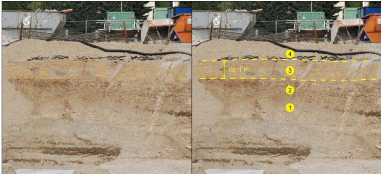
Abb. 21: Baugrube (R: 43.64200/H: 53.18750) in Memmingen W' der Donaustraße zwischen Baumschulweg und Schönfeldstraße; im Liegenden würmzeitliche, unverfestigte Schmelzwasserschotter (1) des Steinheimer Feldes, die nach oben ohne scharfe Grenze in einen verbraunten Verwitterungshorizont (2) übergehen. Darüber liegt ca. 1 m mächtiger, kalkfreier Lösslehm (3), der am Baugrubenrand von kiesigem Bauaushub (4) überlagert wird. Photo des Verfassers vom 4.7.2010.
