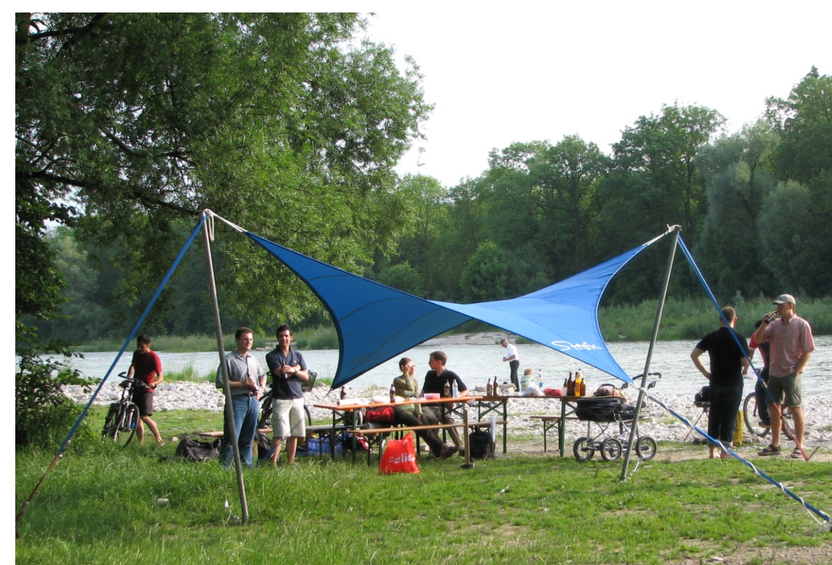
„Statik-Prototyp“ Prototyp eines 4-Punktsegel aufgrund von Simulationsergebnissen für Formfindung und Zuschnitt
