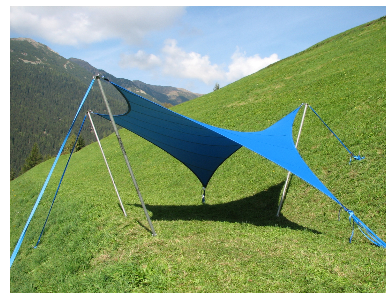
Realisierung eines 5-Punktsegels mit den am Lehrstuhl für Statik entwickelten Methoden für Formfindung und Zuschnitt
