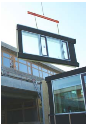
Bild 5: TES-Element bei der Montage. Figure 5: Erection of TES-Element
