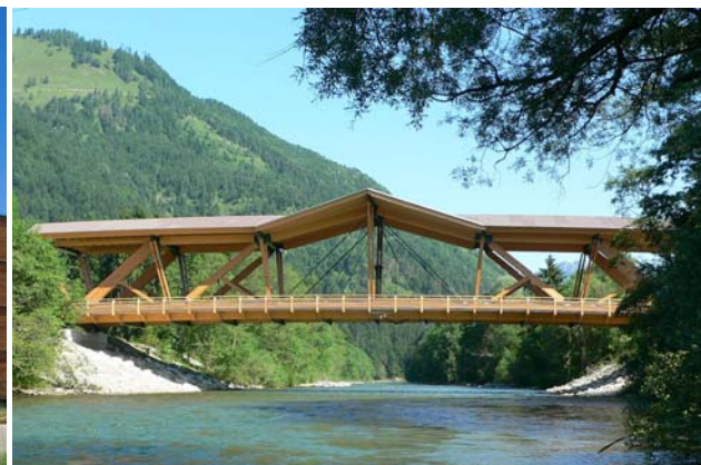
Bild 7 / Figure 7: Staffenbrücke Kössen (Bild: Grossmann Bau)
