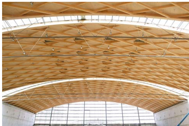
Bild 4 / Figure 4: Neue Messe Karlsruhe (Bild: WIEHAG GmbH, Gerber Architekten)
