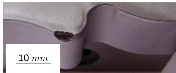
(b) Kantenausbruch [HP07]
