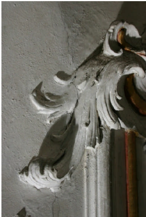
Abb. 290 Detail der rechten Wand oberhalb der Eingangstür im Erdgeschoss - Reinigungsmuster
