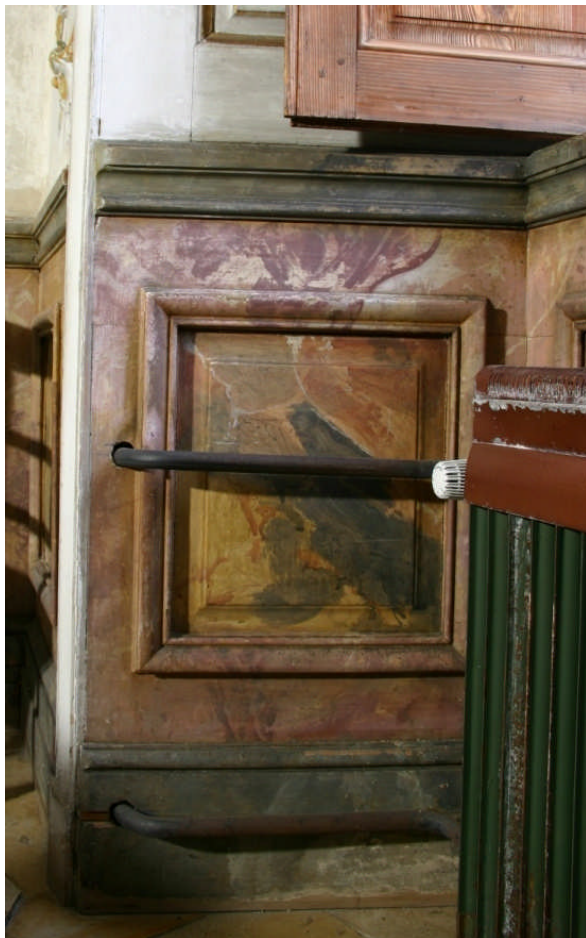
Abb. 58 Fensterwand Boiserie Füllung VI
