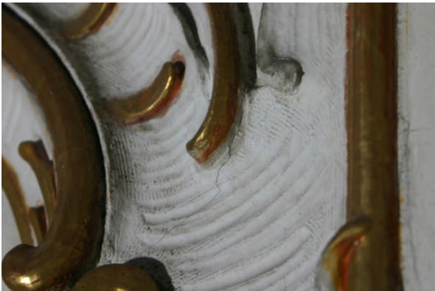
Abb. 261 Detail linke Wand im Erdgeschoss – Arbeitsspuren
