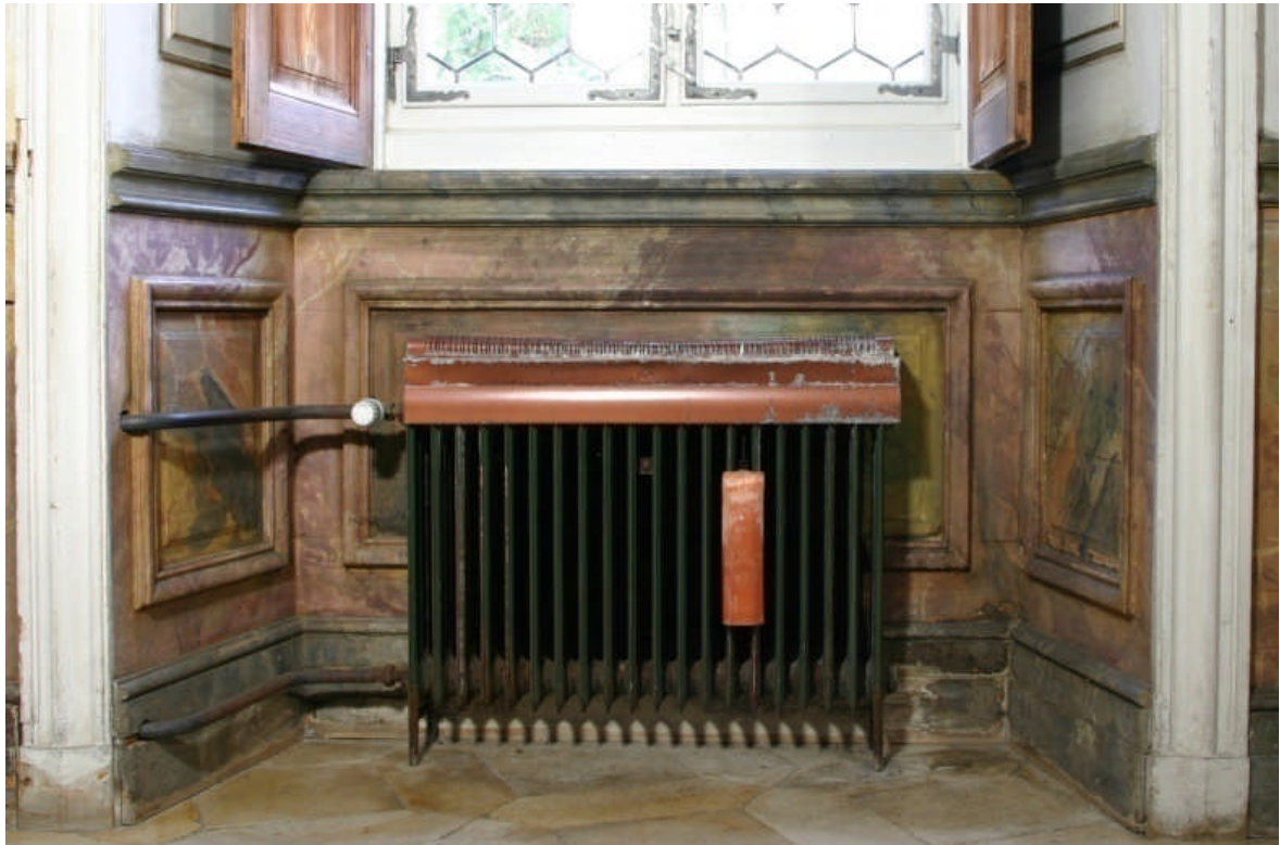
Abb. 57 Fensterwand Boiserie Füllung VI-VIII
