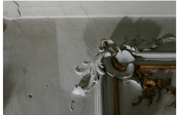
Abb. 289 Detail der rechten Wand oberhalb der Eingangstür im Erdgeschoss – Reinigungsmuster
