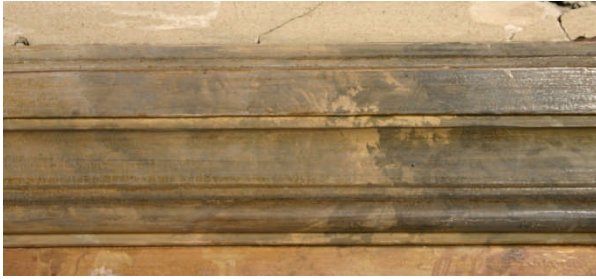
Abb. 67 Profilgesims der Boiserie
