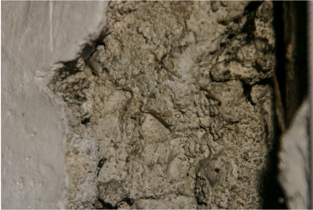
Abb. 253 Detail Putzausbruchstelle, erstes Obergeschoss; rechte Wand am Übergang zwischen Empore und Wandfläche
