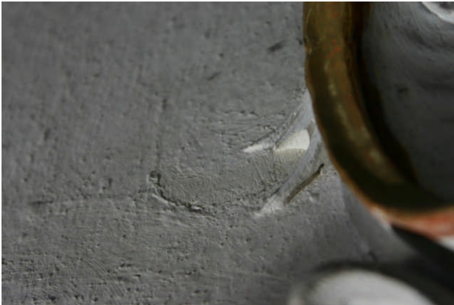
Abb. 270 Detail linke Wand Erdgeschoss oberhalb des ersten Fensters
