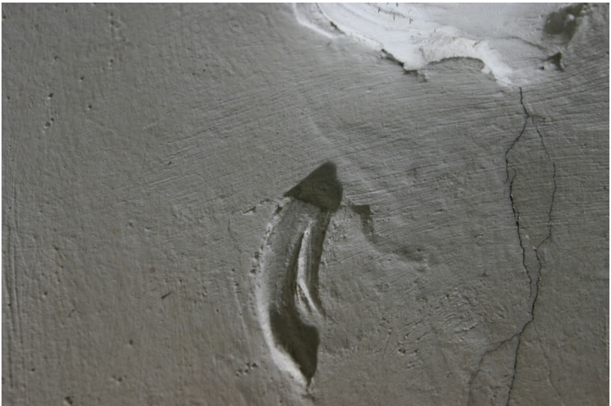
Abb. 273 Detail rechte Wand oberhalb der Eingangstür – Überarbeitung der ursprünglichen Kalkfassung
