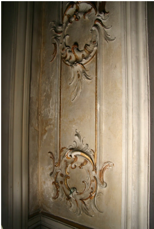
Abb. 277 rechtes Wandstück auf der Empore
