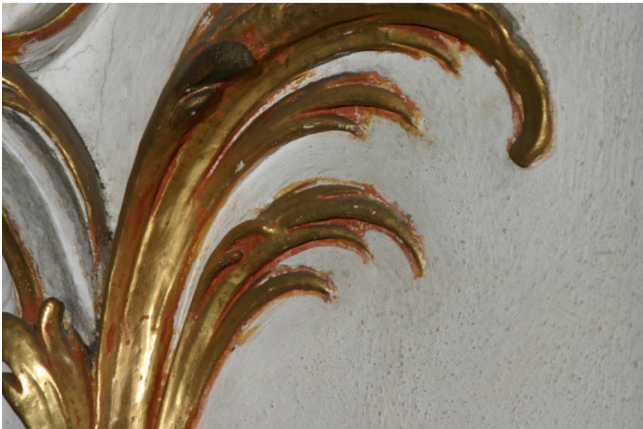
Abb. 141 Detail Stuckvergoldung an der rechten Wand oberhalb der Empore
