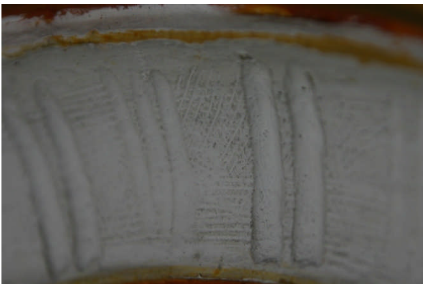
Abb. 262 Detail linke Wand im Erdgeschoss - Arbeitsspuren
