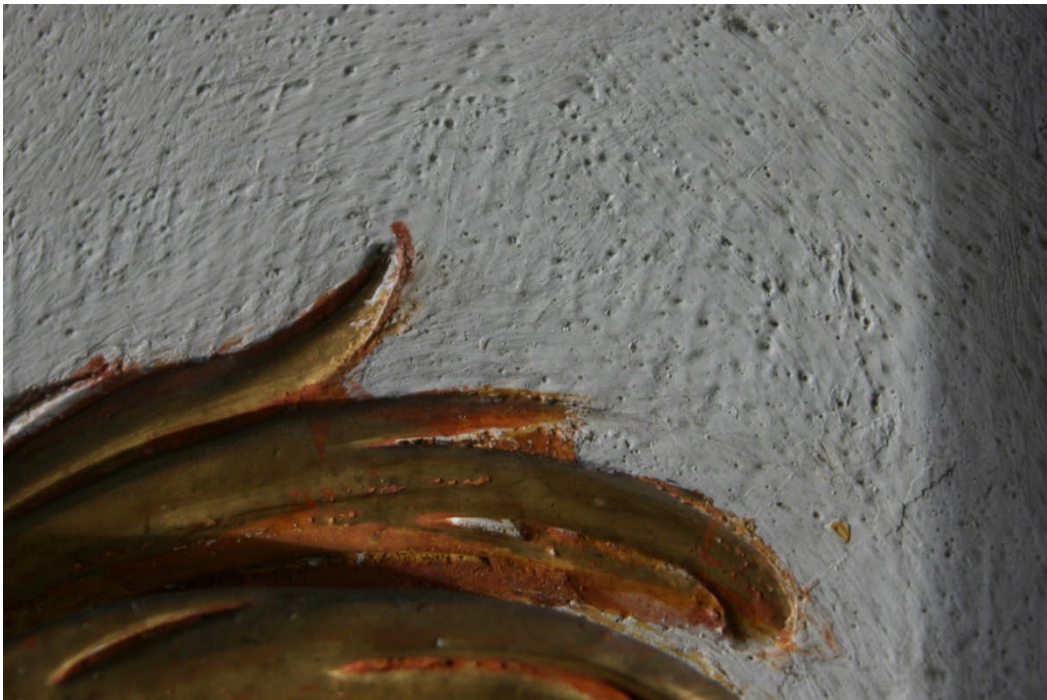
Abb. 255 Detail rechte Wand auf der Empore – kammartige Arbeitsspuren
