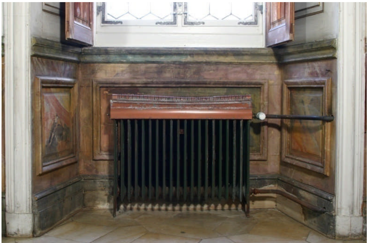
Abb. 61 Fensterwand Boiserie Füllung XII-XIX
