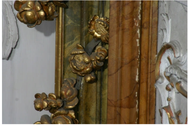
Abb. 105 Befestigung der vergoldeten Ornamente an Relieffrahmen durch Bandeisen
