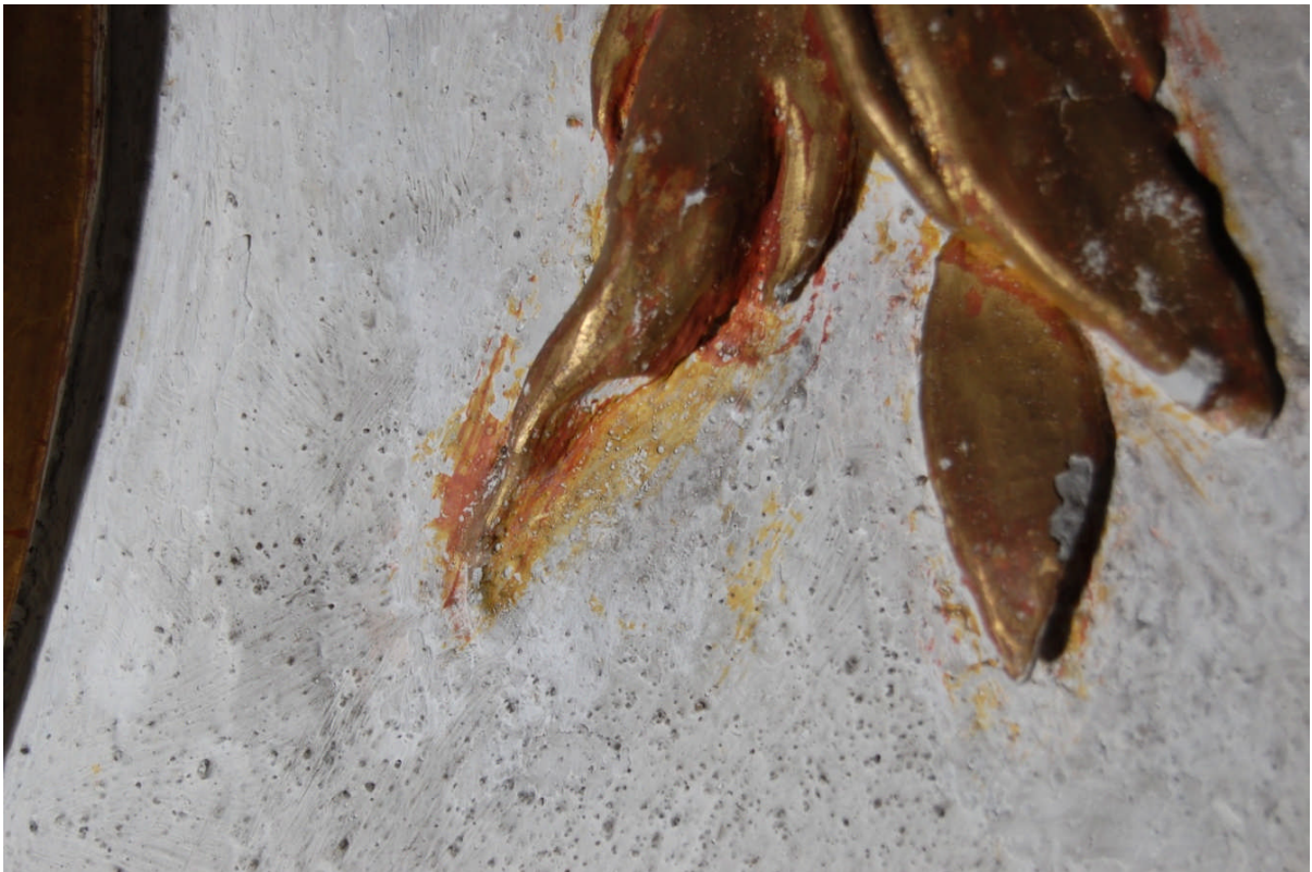
Abb. 272 Detail Fensterwand im mittleren Wandfeld des Erdgeschosses
