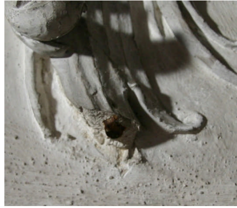
Abb. 264 Detail Fensterwand auf der Empore im mittleren Wandstück – Eisenarmierung
