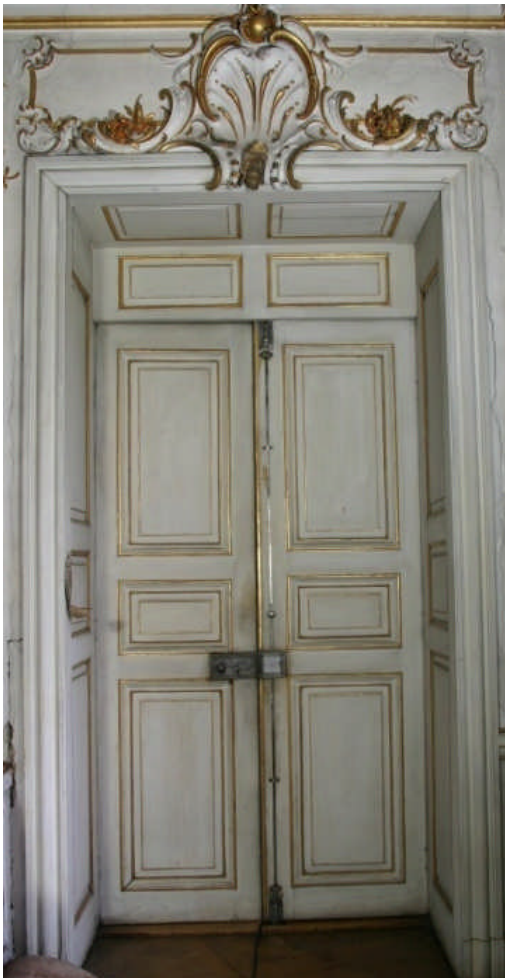
Abb. 16 rechte Tür im ersten Geschoss
