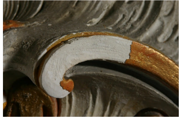
Abb. 283 Detail Fensterwand auf der Empore
