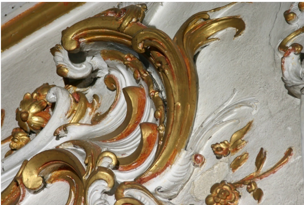
Abb. 142 Detail Stuckvergoldung an der rechten Wand oberhalb der Empore
