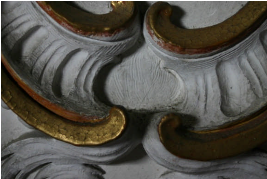
Abb. 260 Detail Fensterwand auf der Empore im mittleren Wandstück - Arbeitsspuren
