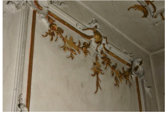
Abb. 276 Detail rechte Wand oberhalb der Eingangstür
