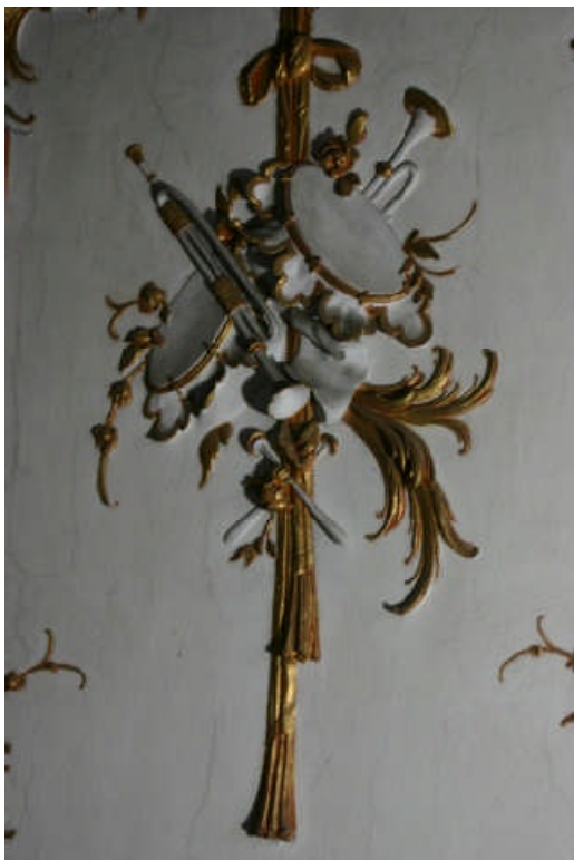
Abb. 30 rechte Wand Draperie erstes Obergeschoss
