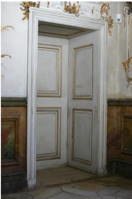
Abb. 102 Detail rechte Tür im Erdgeschoss
