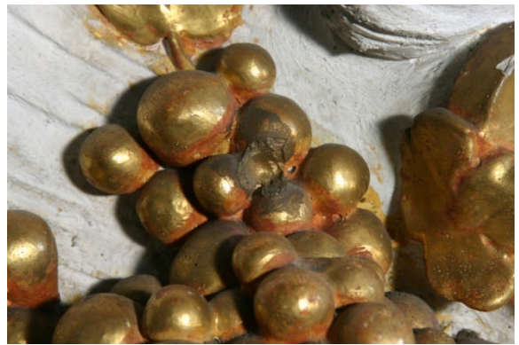
Abb. 137 Detail Stuckvergoldung an der rechten Wand im Erdgeschoss
