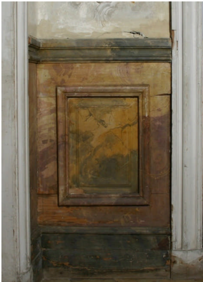
Abb. 56 Fensterwand Boiserie Füllung V
