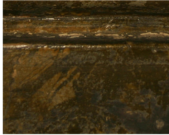
Abb. 227 Detail Gesims der Boiserie
