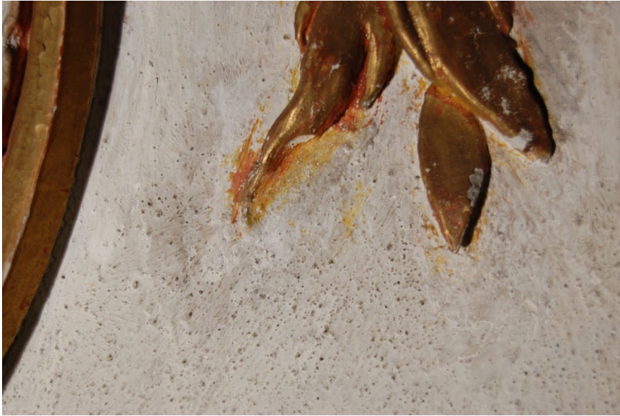
Abb. 143 Detail mittlere Fensterwand im Erdgeschoss
