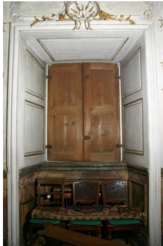
Abb. 17 rechtes Fenster im Erdgeschoss
