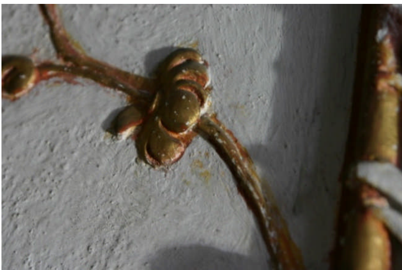
Abb. 271 Detail rechte Wand oberhalb der Empore
