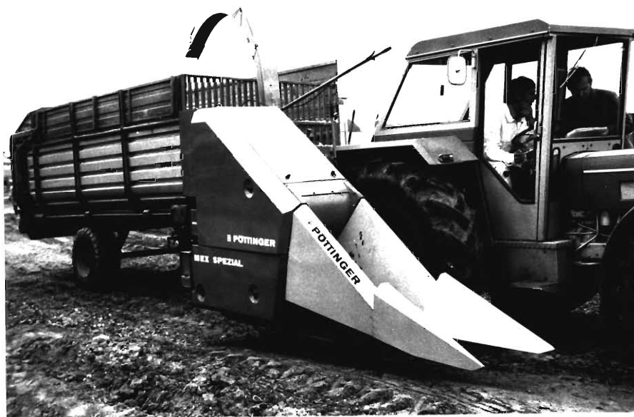
Abb. 70: Spezial-Pflückschroter mit Entlieschvorrichtung
